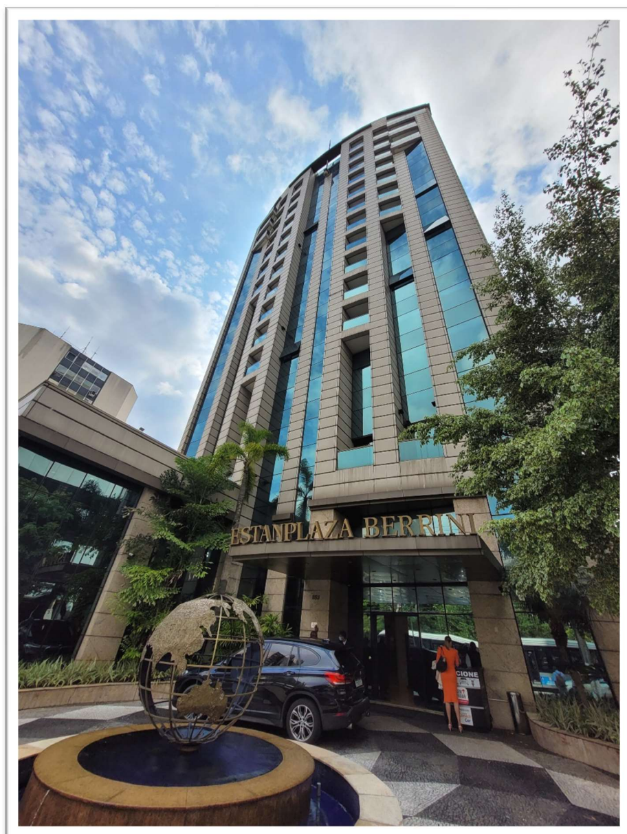
FOTO 01 – FACHADA DE FRENTE DO CONDOMÍNIO
