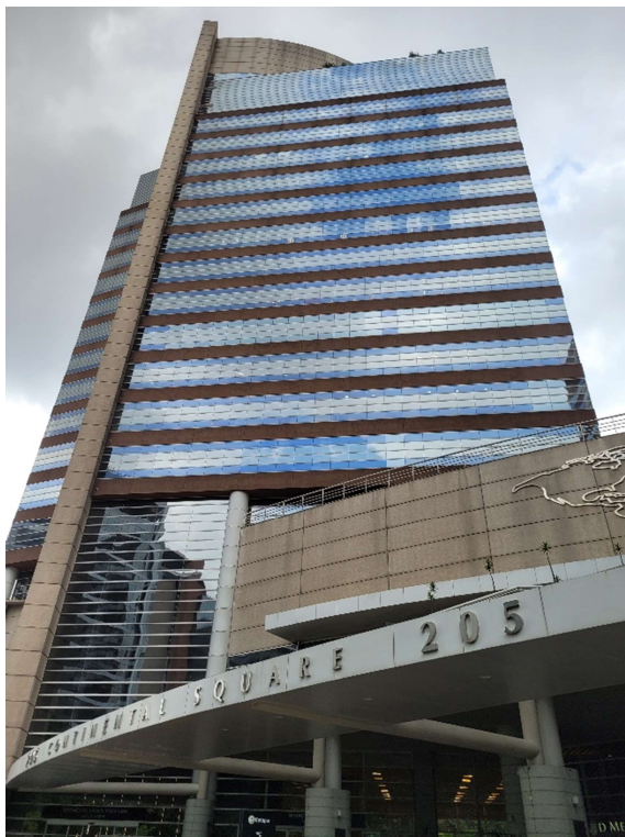
FOTO 01 – FACHADA DE FRENTE DO CONDOMÍNIO
