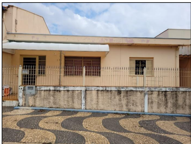
Vista geral da edificação
