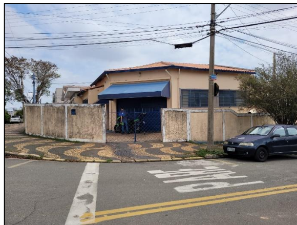
Vista geral da edificação
