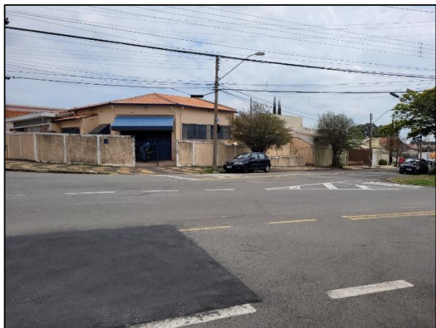
Vista geral do imóvel
