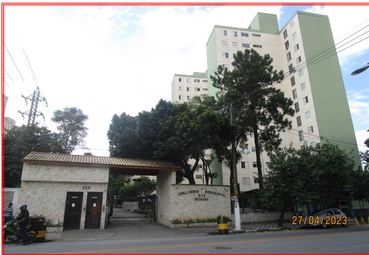
Foto nº 01: Vista geral da portaria do Condomínio Residencial das Acácias, localizada na Rua Paula Rodrigues.
