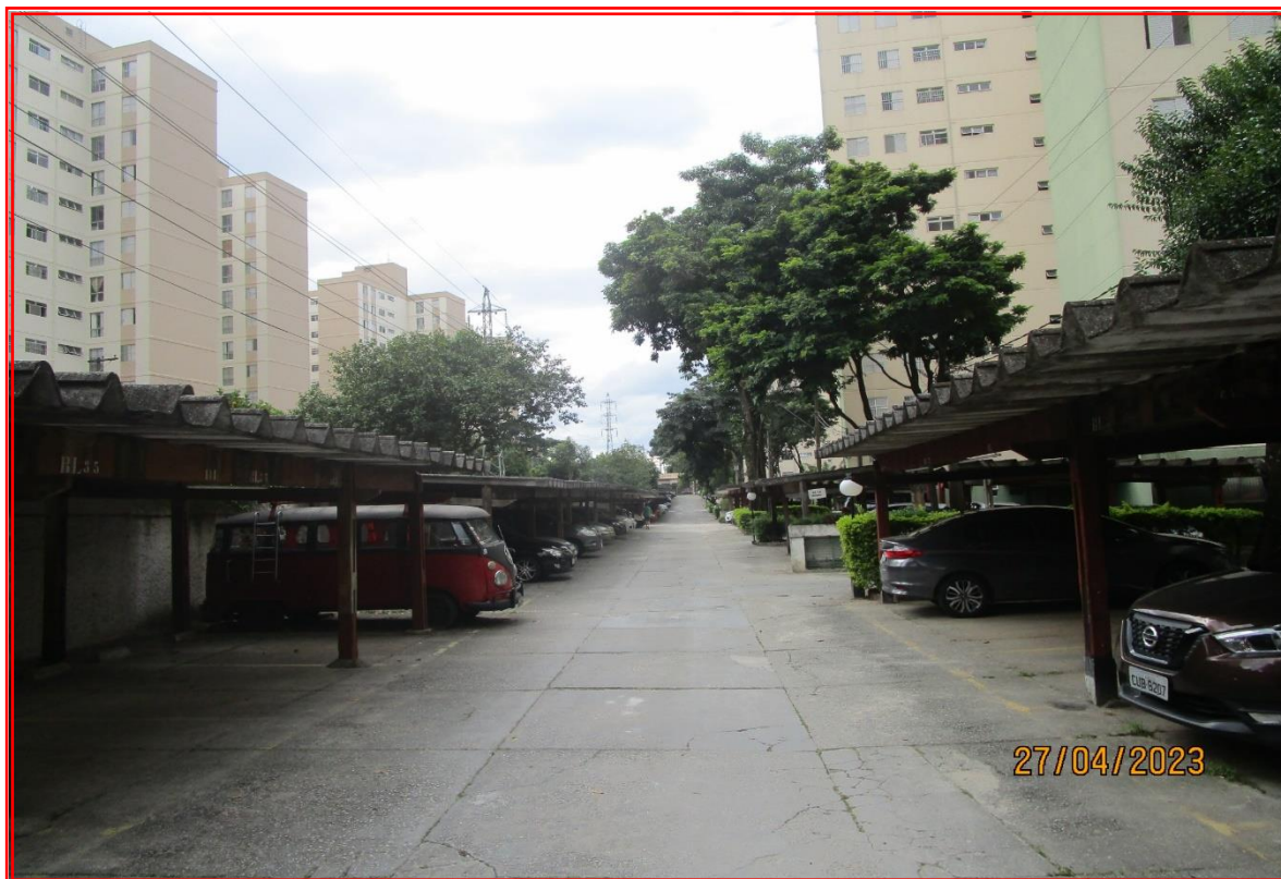
Foto nº 03: Vista geral da alameda central de circulação e de acesso aos blocos de apartamentos residenciais do condomínio.
