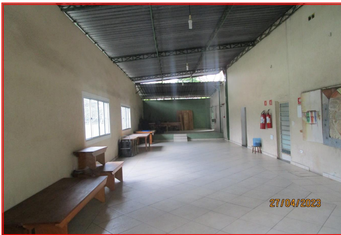
Foto nº 06: Vista parcial do salão de festas de uso coletivo dos condôminos.
