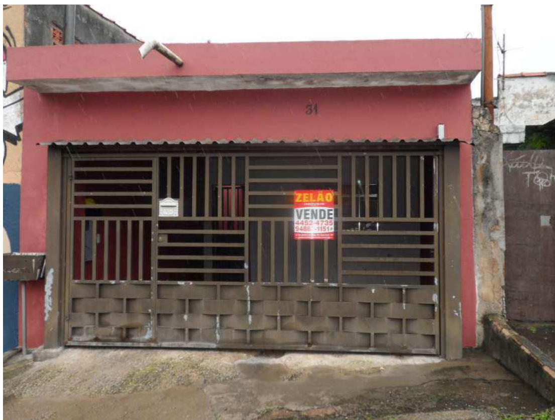
IMÓVEL LOCALIZADO NA RUA HENRIQUE DIAS, 31 – JARDIM ACLIMAÇÃO – SANTO ANDRÉ – SP, UTILIZADA PARA A COMPARAÇÃO.
