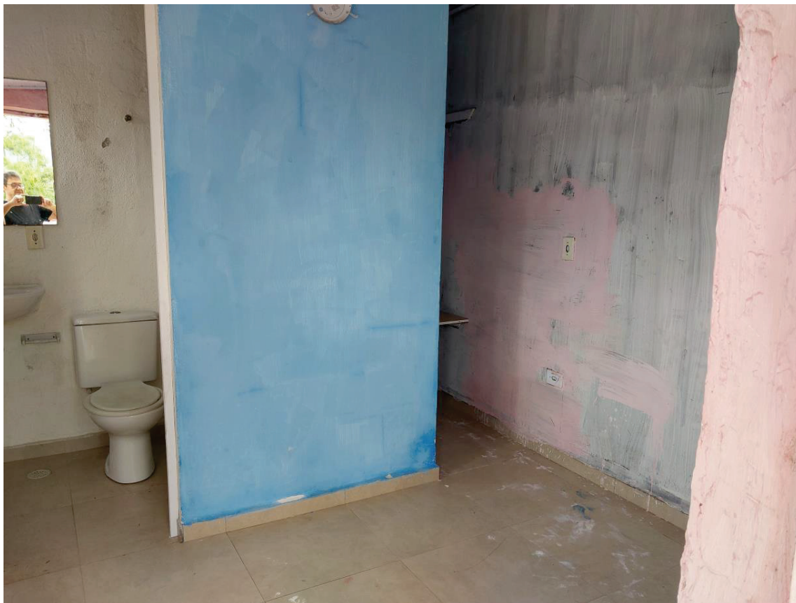
Foto 32: Vista parcial interna dos quartos do andar superior.
