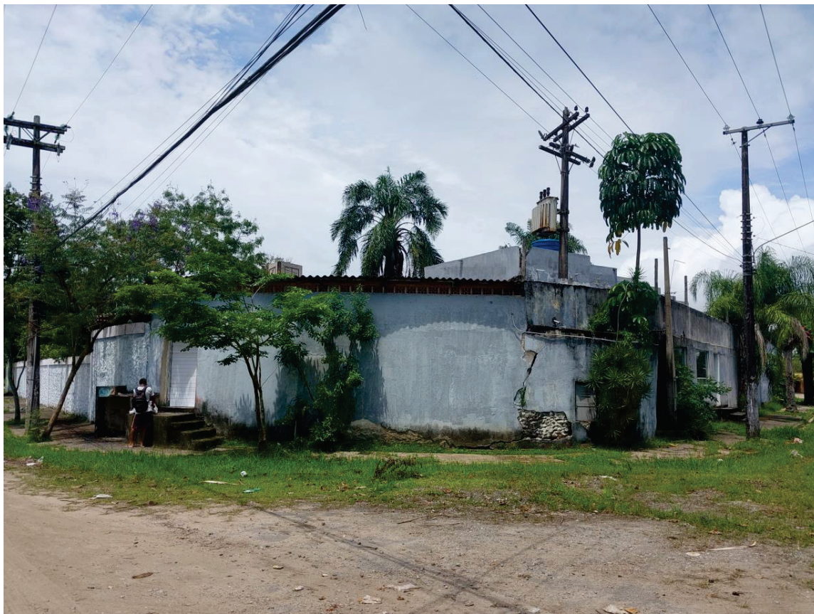
Foto 3: Vista geral externa dos fundos do imóvel.
