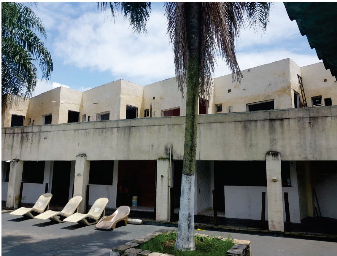
Foto 29: Vista geral da fachada interna do imóvel.
