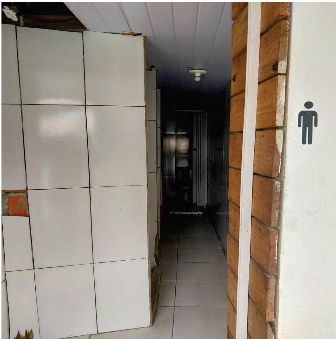
Foto 17: Vista geral dos banheiros/vestiários.
