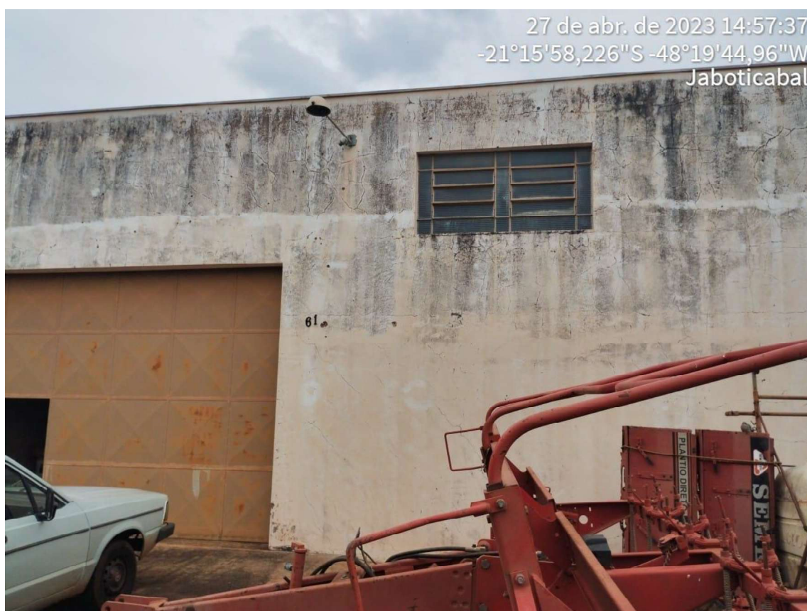
Figura 6 Entrada principal do Galpão
