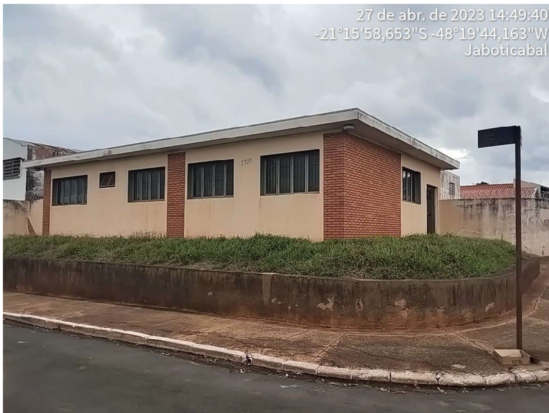
Figura 4 Fachada do escritório
