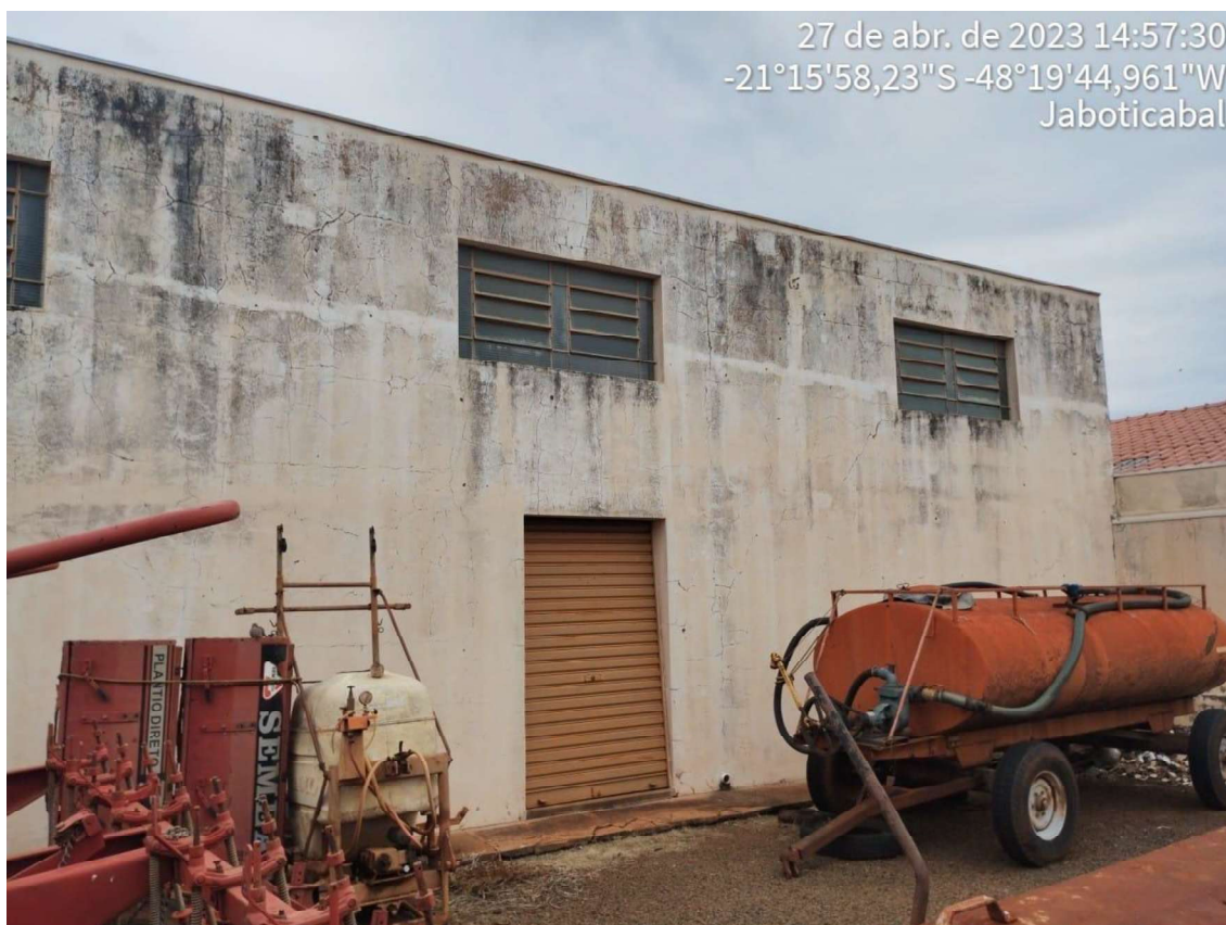
Figura 5 Fachada do Galpão
