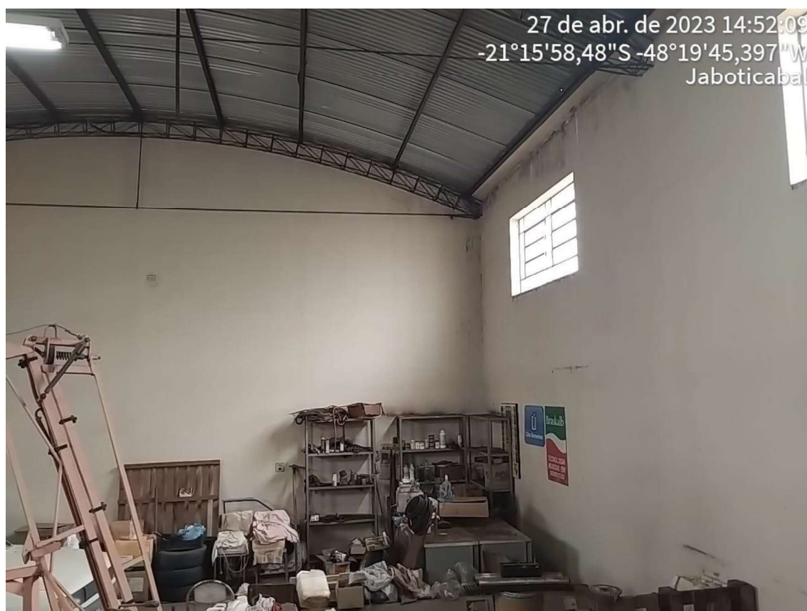
Figura 14 Área interna do Galpão
