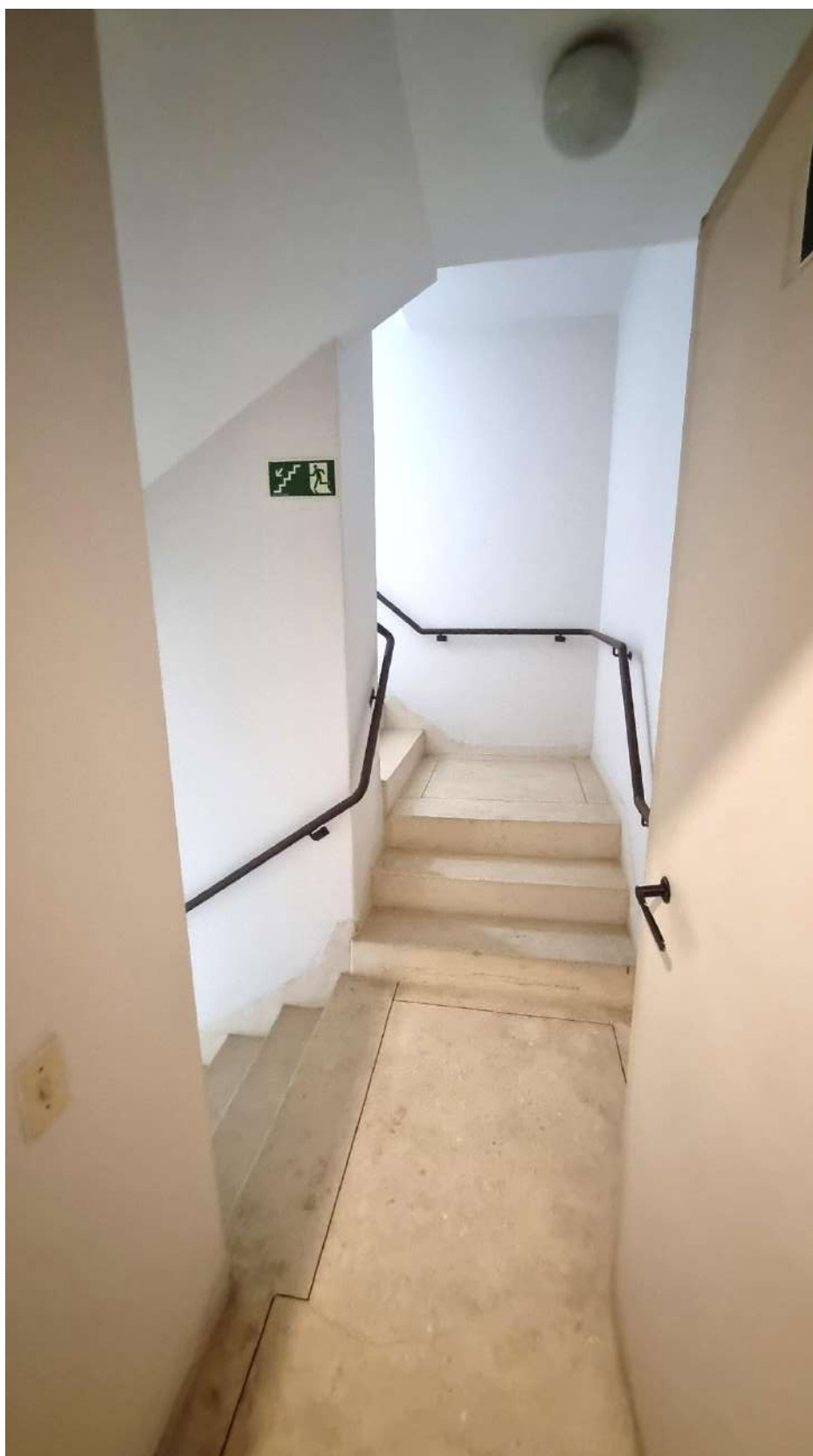
Foto 63 – Vista da escada junto ao hall de serviço
