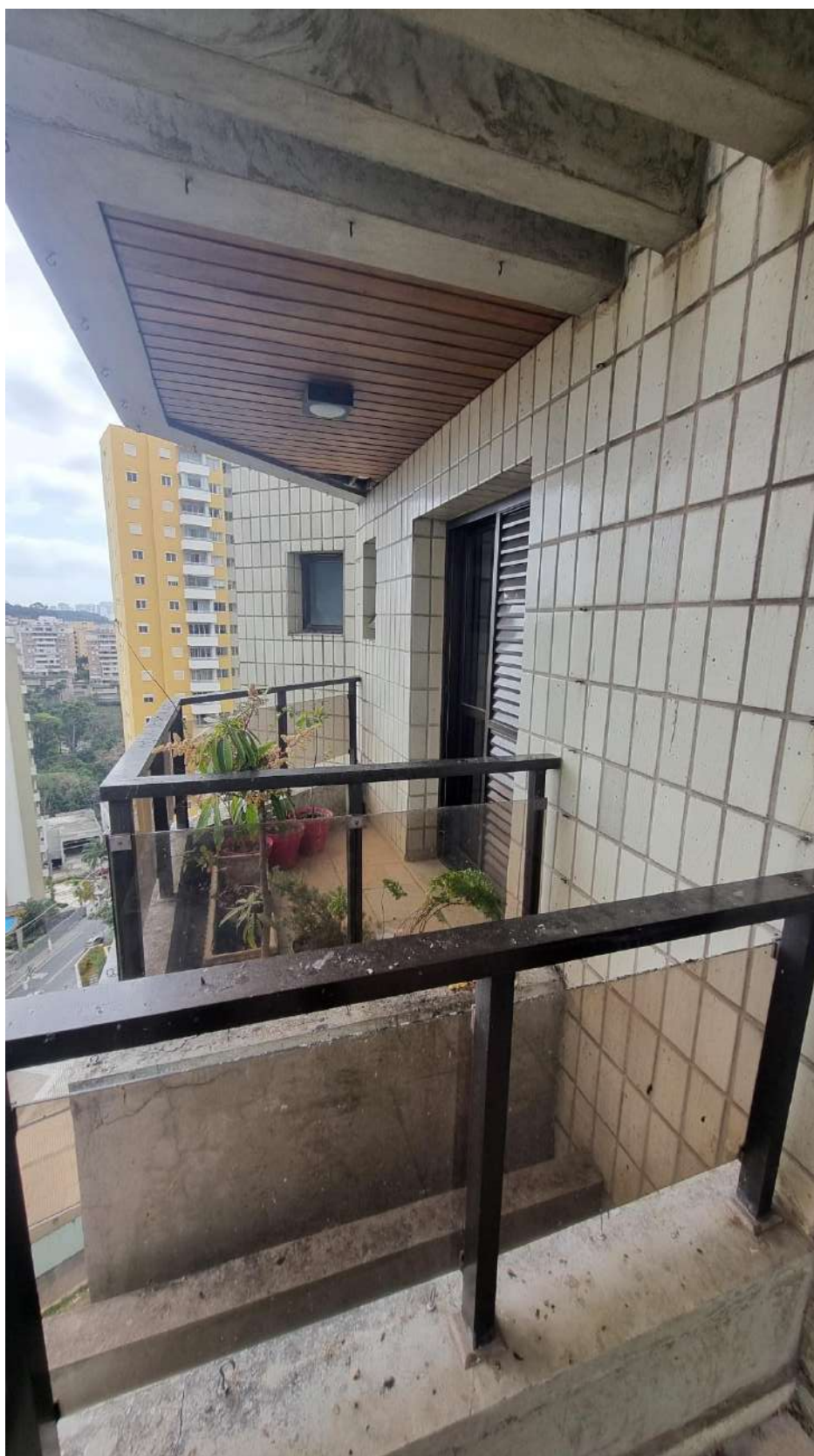
Foto 68 – Vista da varanda da suíte 2
