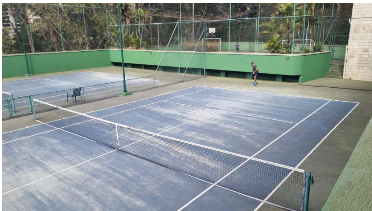
Foto 25 – Vista das quadras de tênis
