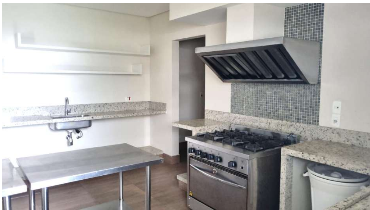
Foto 13 – Vista da cozinha do salão de festas
