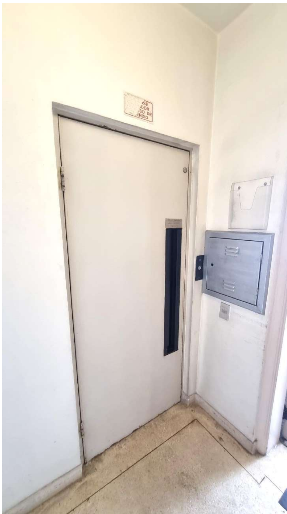
Foto 61 – Vista do hall de serviço
