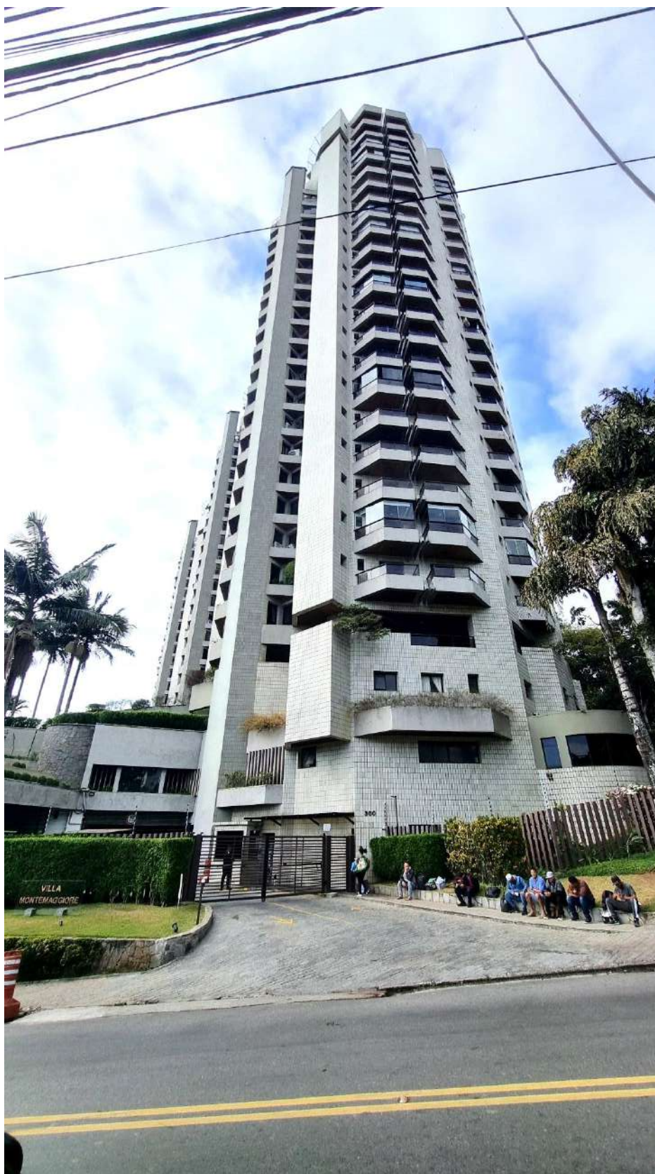
Foto 01 – Vista da fachada do condomínio do imóvel
