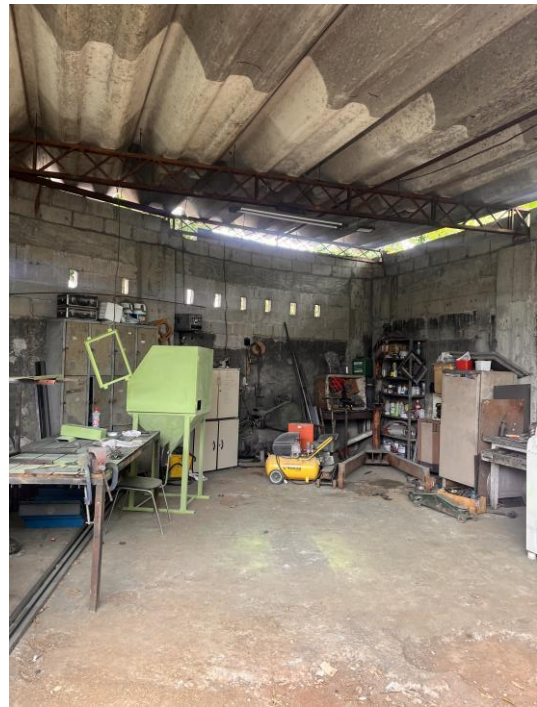
Fig. 8 – Ferramentaria de 55m2 de área aos fundos.
