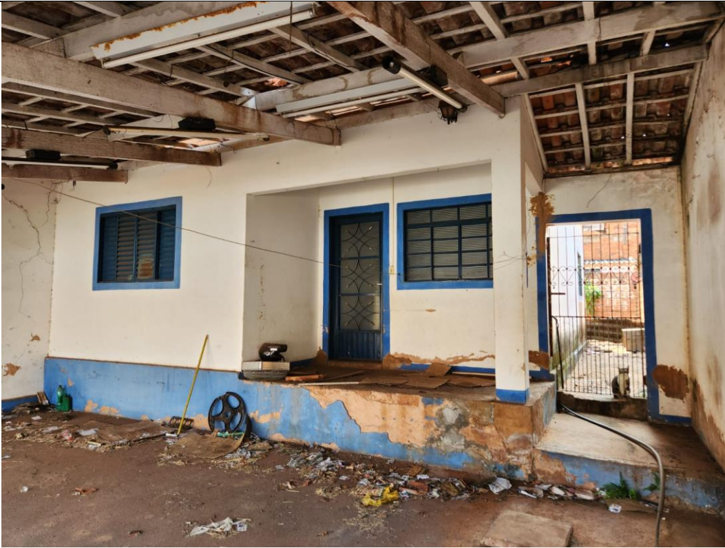
Vista interna do imóvel, observando a porta de acesso, garagem e lateral direita.
