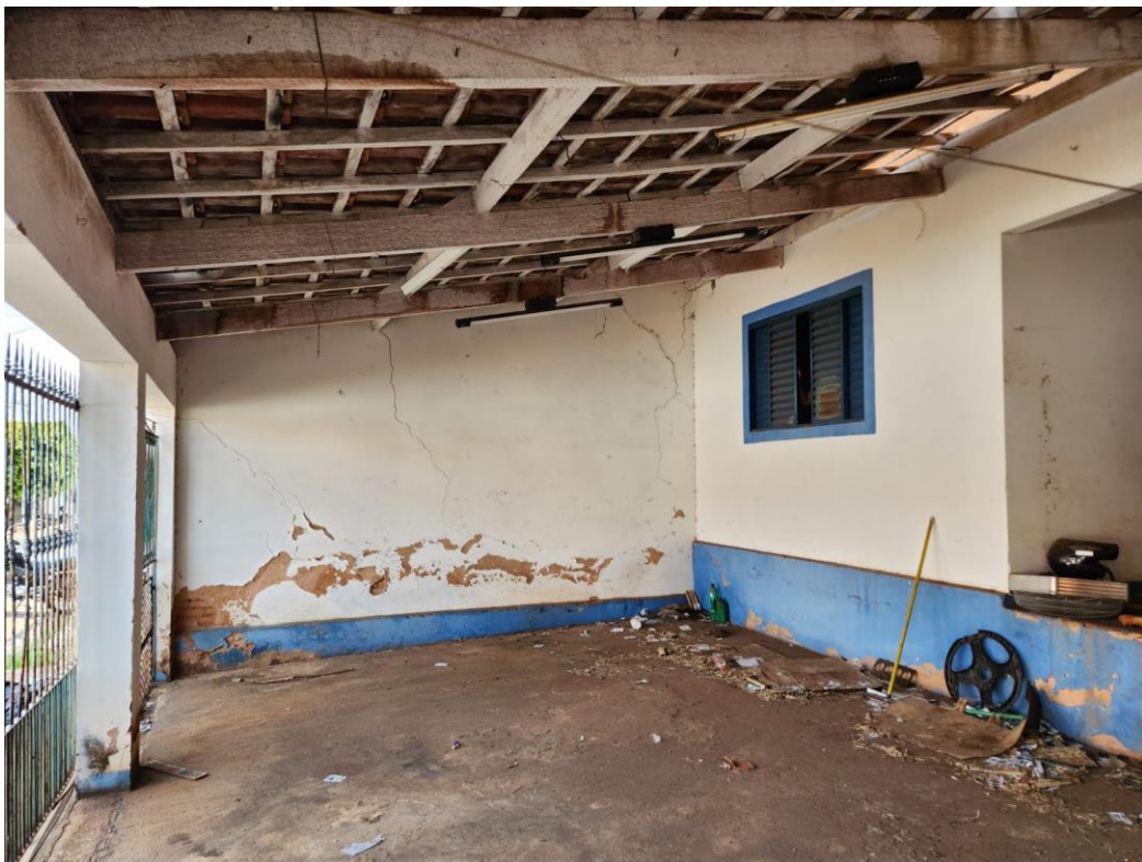
Vista interna do imóvel, observando a fachada interna e garagem.
