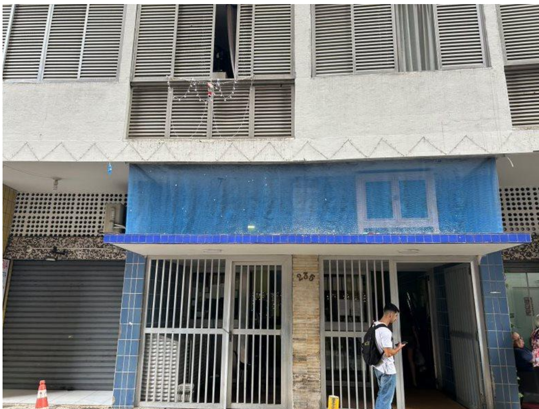
Foto 1 – Fachada do Edifício
