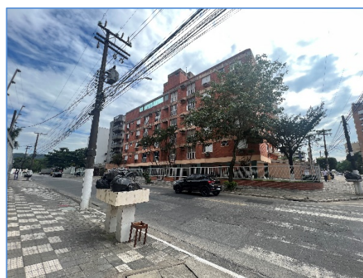
Foto 12- Fachada frontal do edifício
