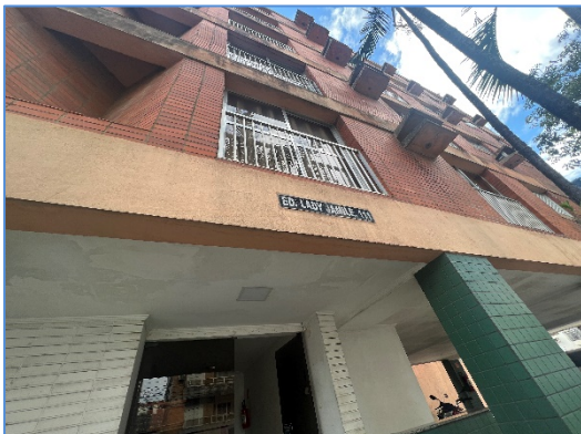
Foto 1 – Fachada frontal do edifício
