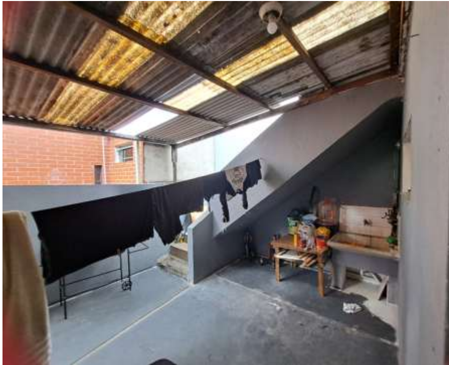
VISTA DA ÁREA DE SERVIÇO COBERTA.
