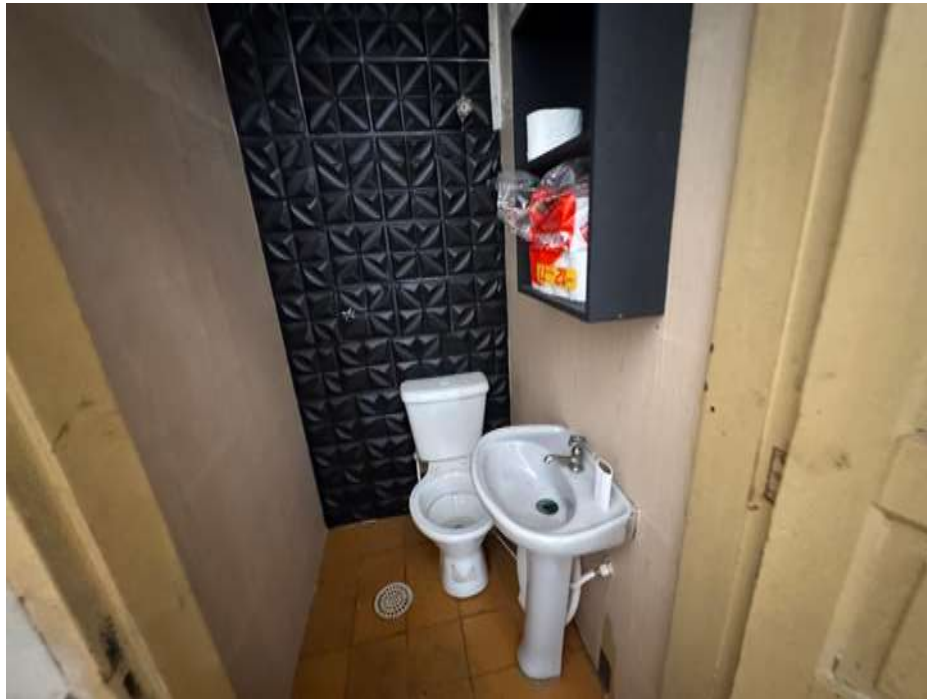
VISTA DO BANHEIRO.
