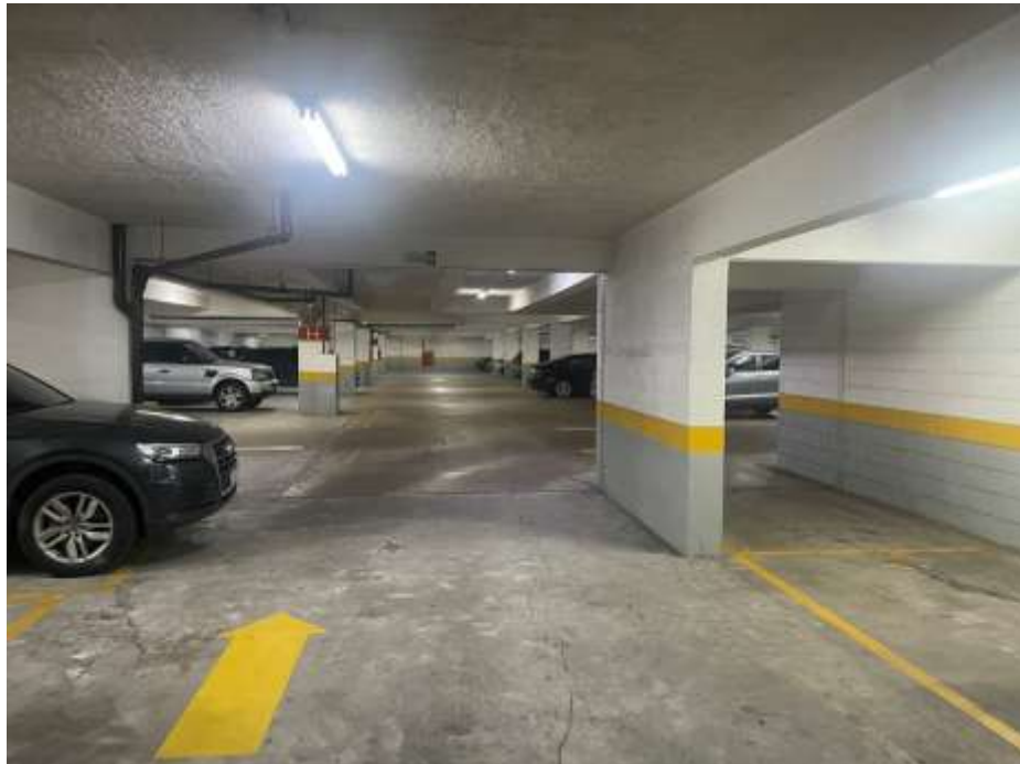
VISTA DO ESTACIONAMENTO.
