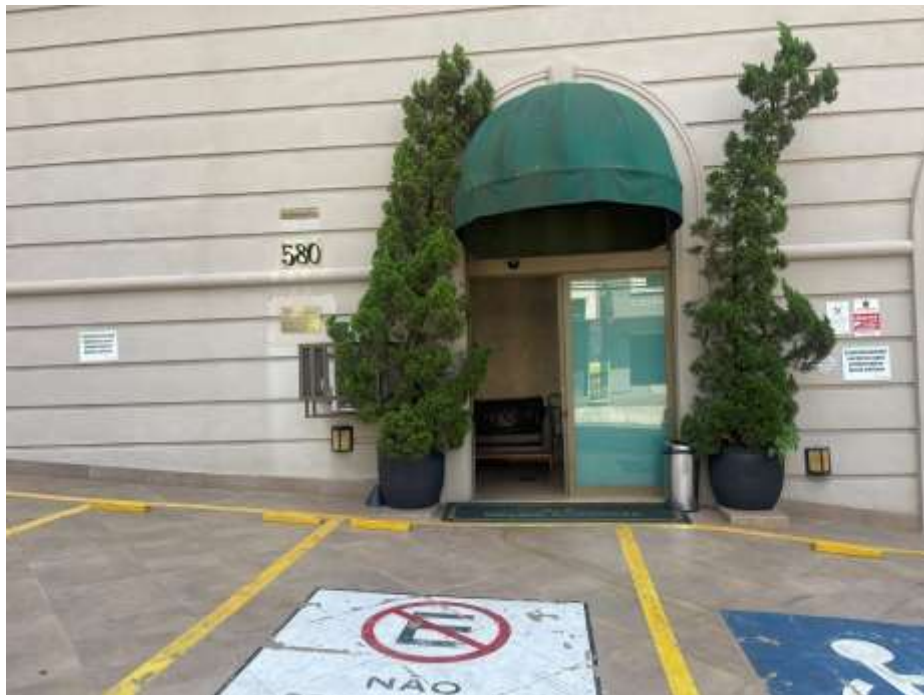
VISTA DA ENTRADA DO EDIFÍCIO.
