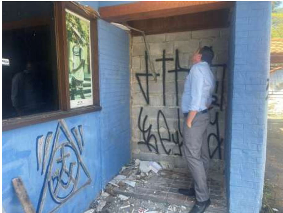
VISTA DO IMÓVEL.
