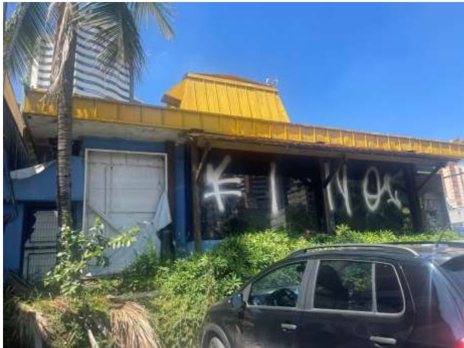
VISTA DA ENTRADA DO IMÓVEL.
