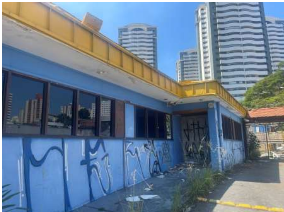
VISTA DO IMÓVEL.
