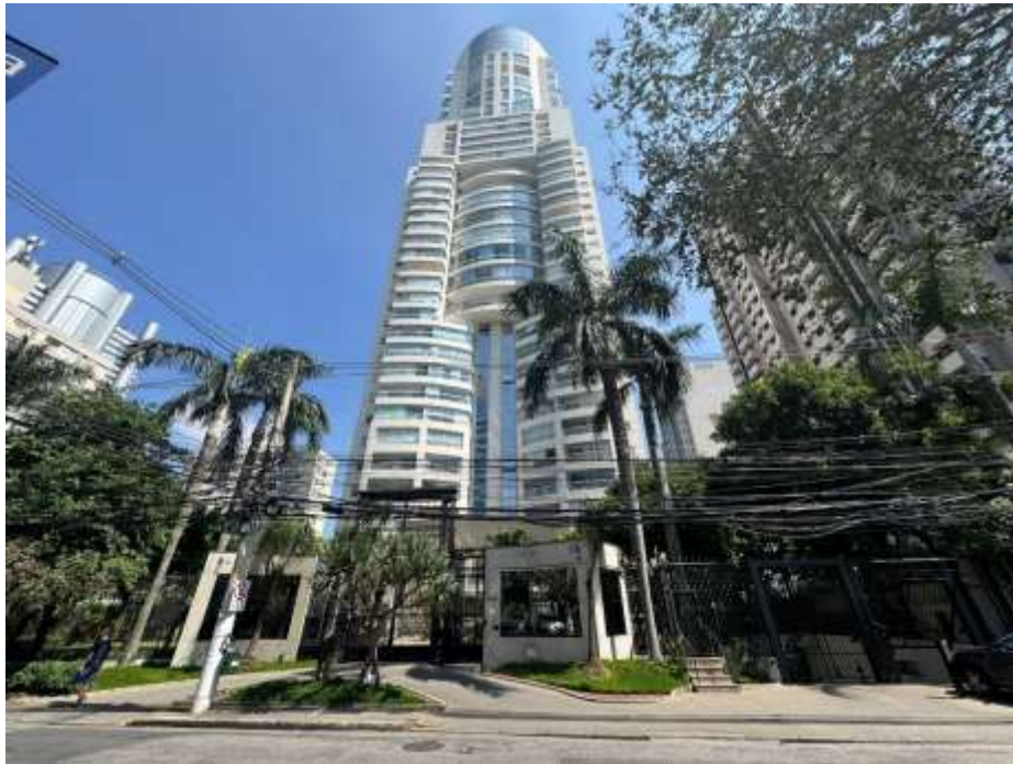
VISTA DA FACHADA DO EDIFÍCIO.
