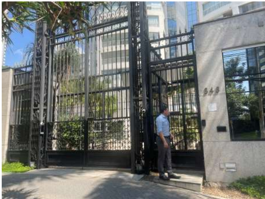
VISTA DA ENTRADA DO EDIFÍCIO.
