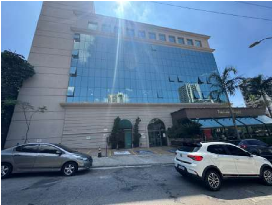
VISTA DA FACHADA DO EDIFÍCIO.
