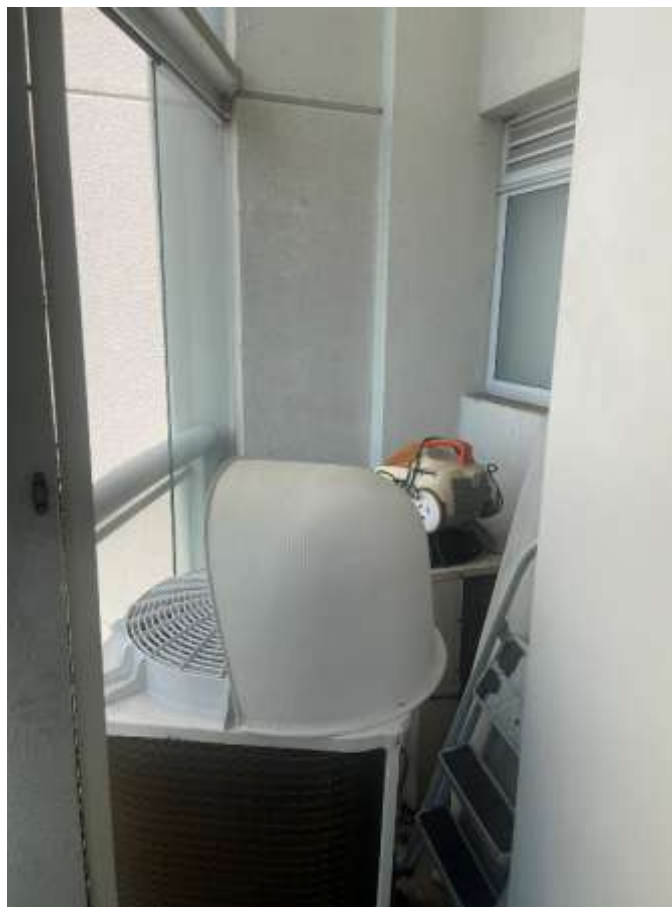
VISTA DA ÁREA TÉCNICA.
