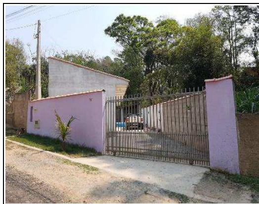
Fachada - Imóvel vizinho em frente
