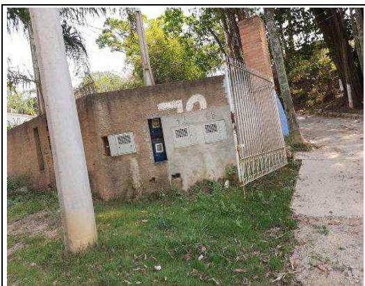
Fachada - Imóvel vizinho em frente
