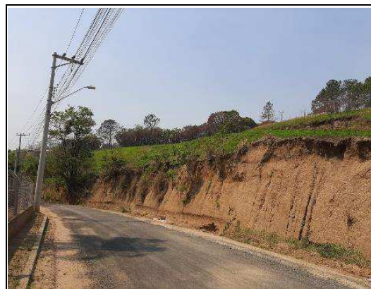
Vista da rua
