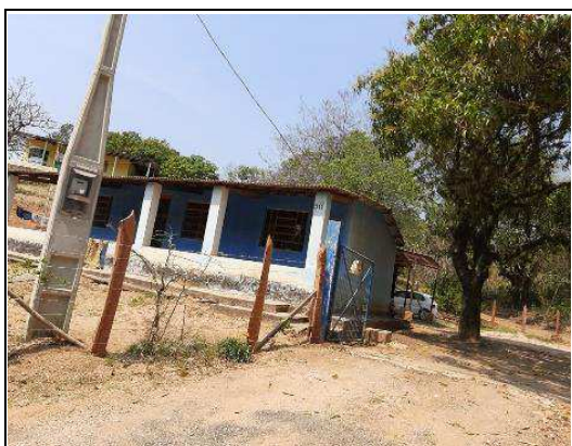
Fachada - imóvel vizinho a direita
