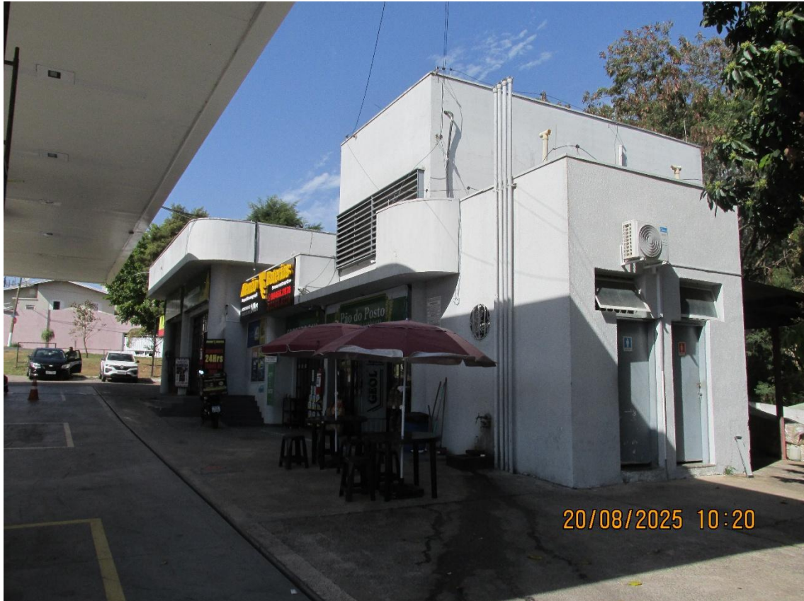
Área Construída (ângulo III)
