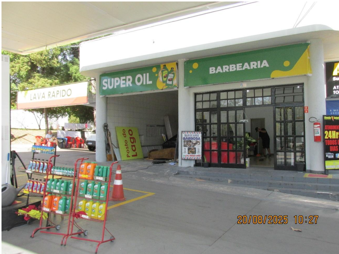
Área Construída (ângulo III)
