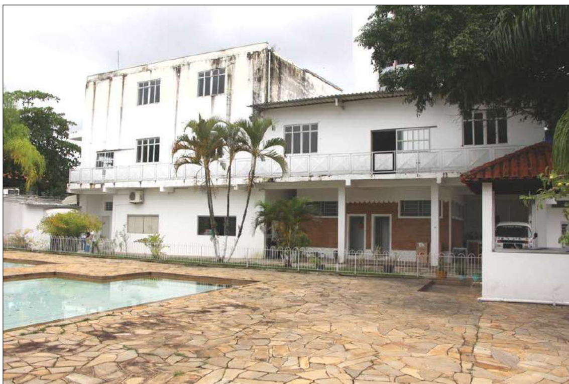
FOTO 03: Vista parcial do prédio principal.
