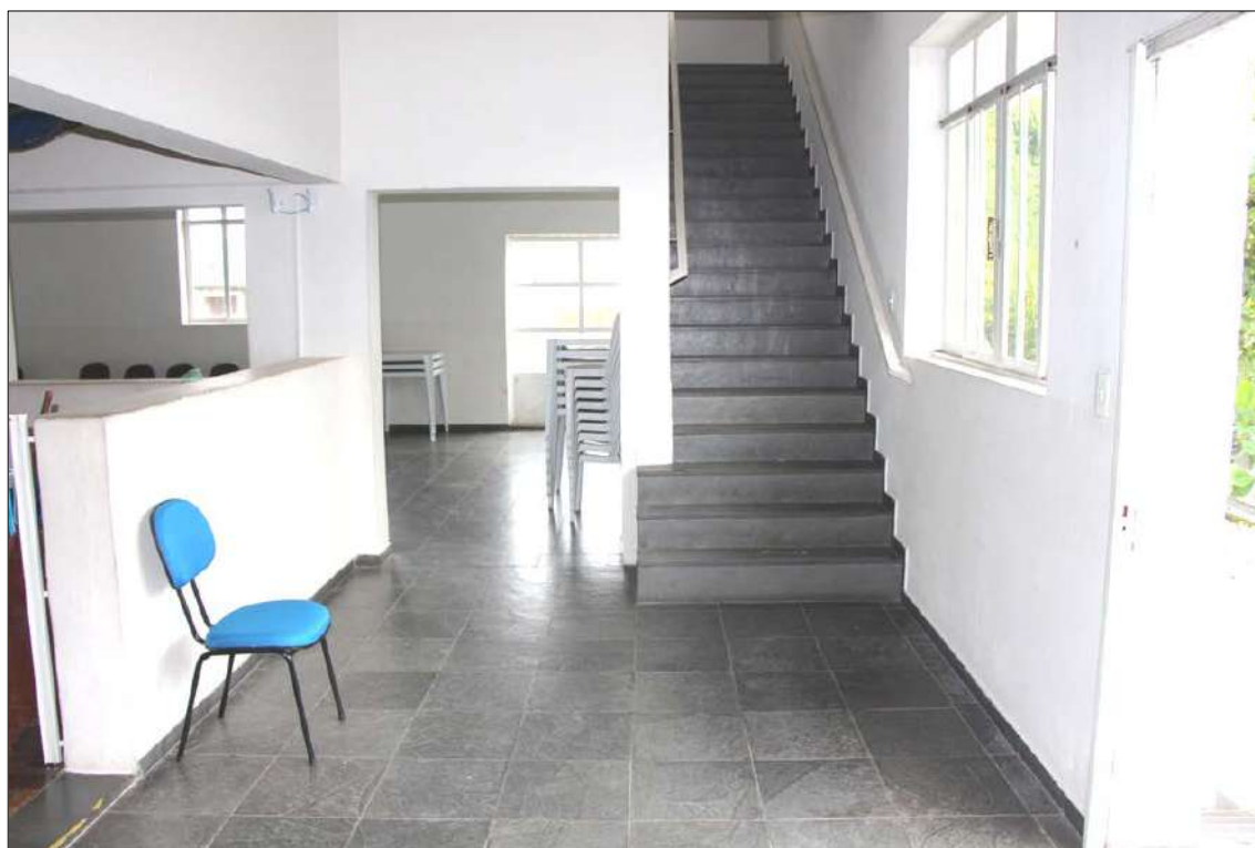
FOTO 19: Escada de acesso ao segundo pavimento.
