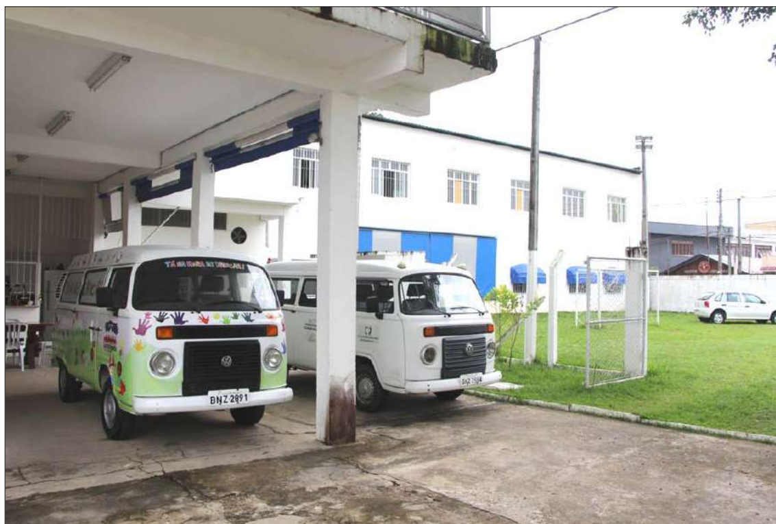
FOTO 04: Vista da parte dos fundos do prédio principal.
