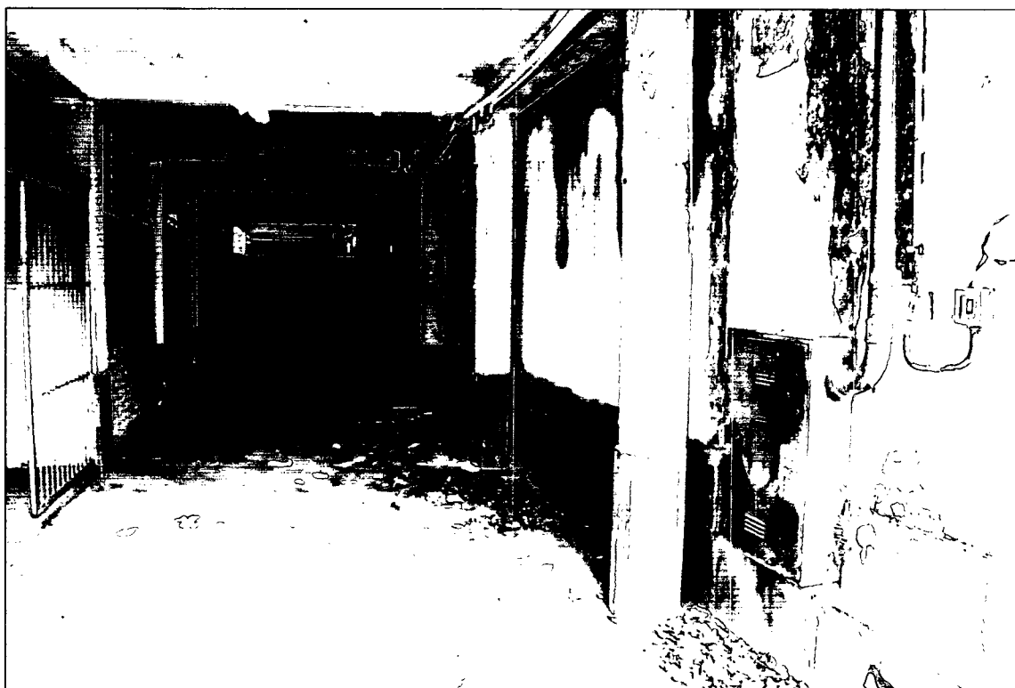
FOTO 09: Corredor de acesso aos vestiários e sanitários do pavimento térreo.
