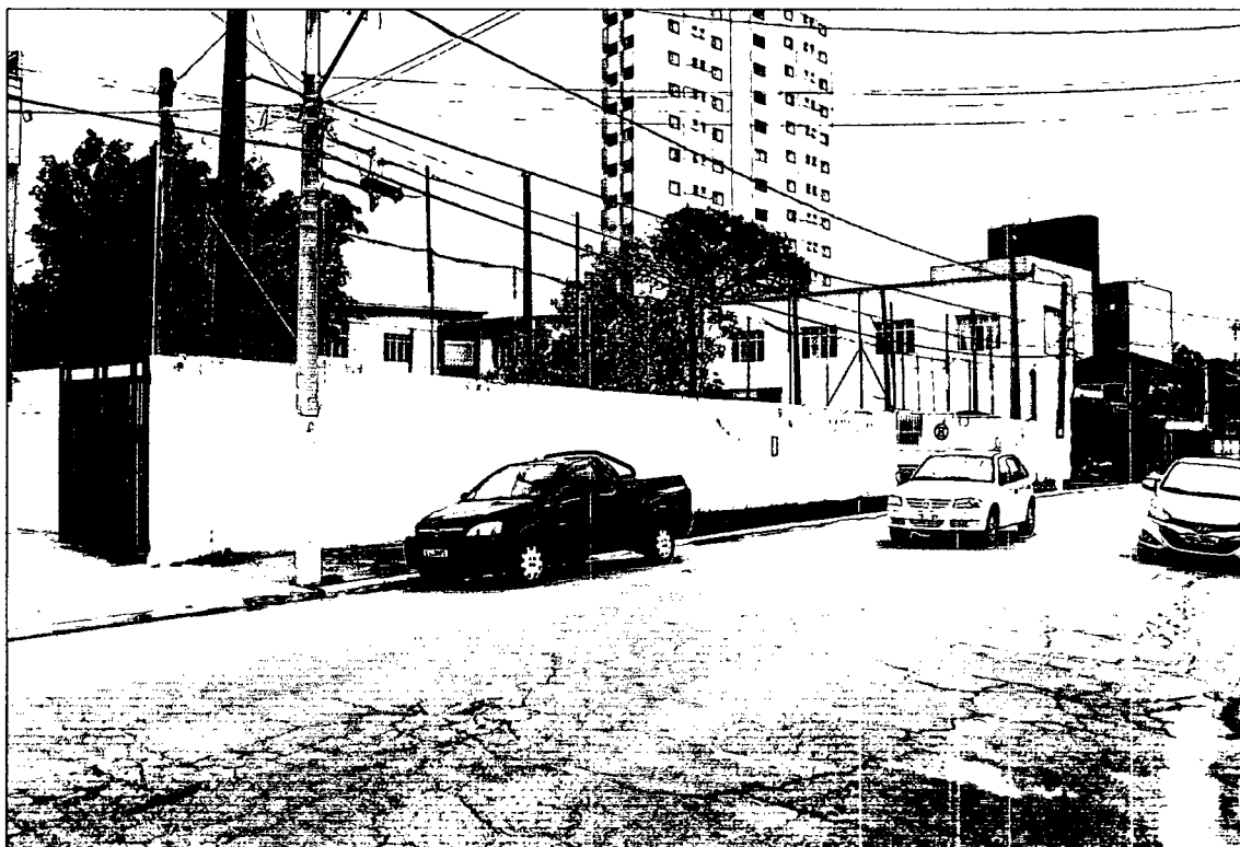
FOTO 14: Acesso secundário do imóvel na Rua Cândido Dinamarco.
