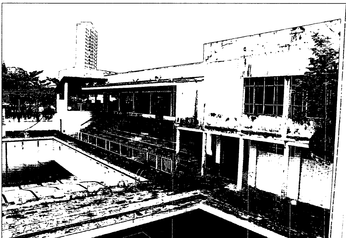
FOTO 25: Conjunto aquático e arquibancadas cobertas.
