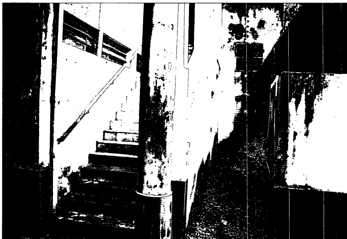
FOTO 30: Escada de serviços do pavimento superior.
