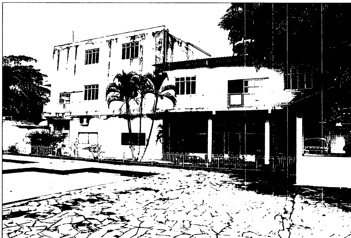
FOTO 03: Vista parcial do prédio principal.
