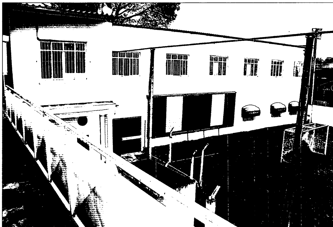
FOTO 05: Observador postado na varanda do primeiro pavimento visualizando a parte dos fundos do prédio principal.
