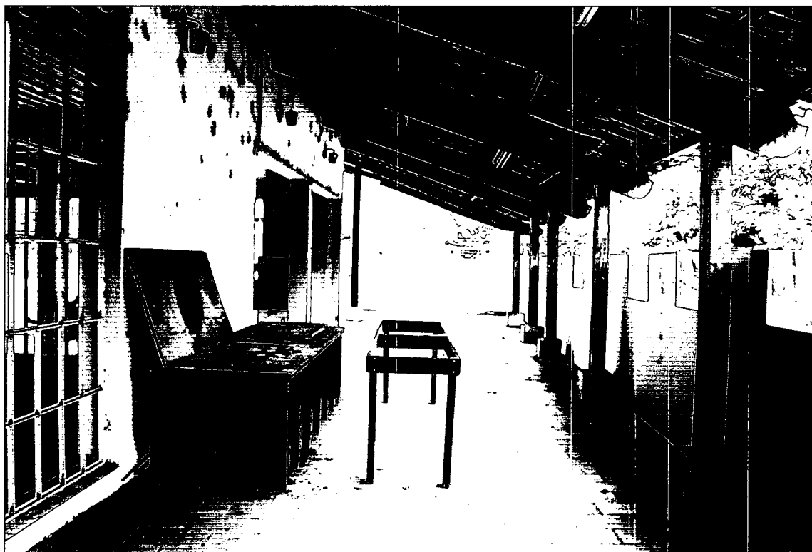
FOTO 20: Vista geral da cobertura existente em parte da área frontal do pavimento superior.
