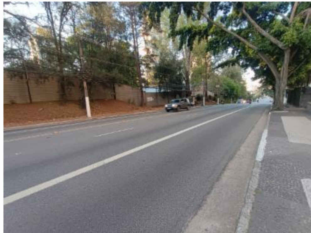
Vista da rua à direita
