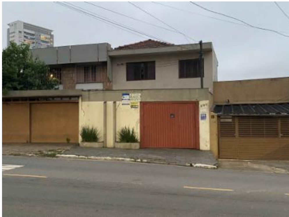
fachada do avaliando
