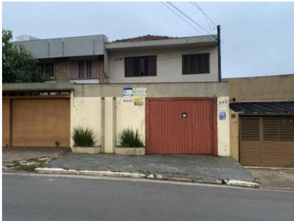
fachada do avaliando
