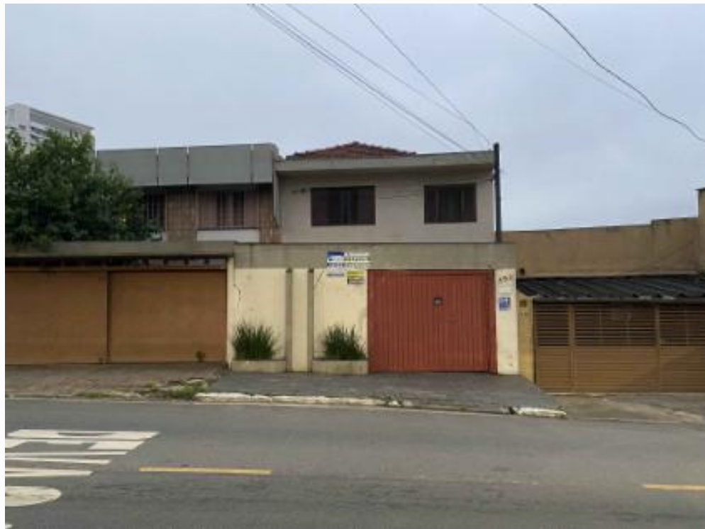
fachada do avaliando
