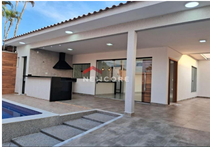
Representação Fachada Principal Descrição Data Foto 26/12/2023
