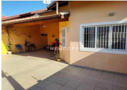
Representação Fachada Principal Descrição Data Foto 26/12/2023
