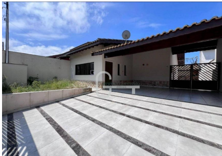
Representação Fachada Principal Descrição Data Foto 26/12/2023
