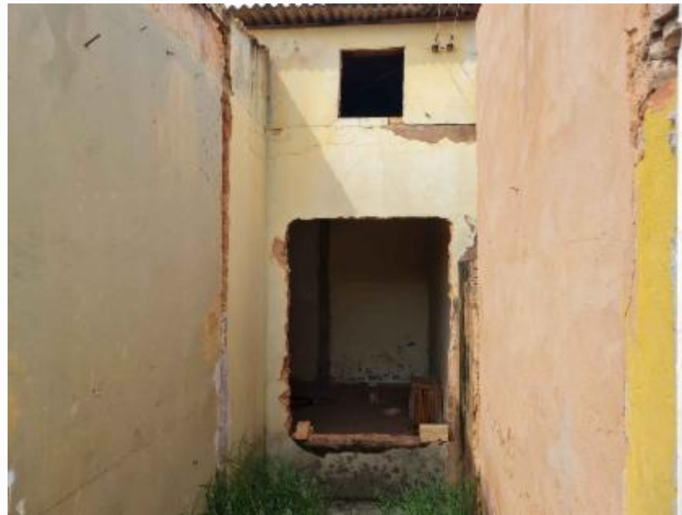
Lateral direita do imóvel
