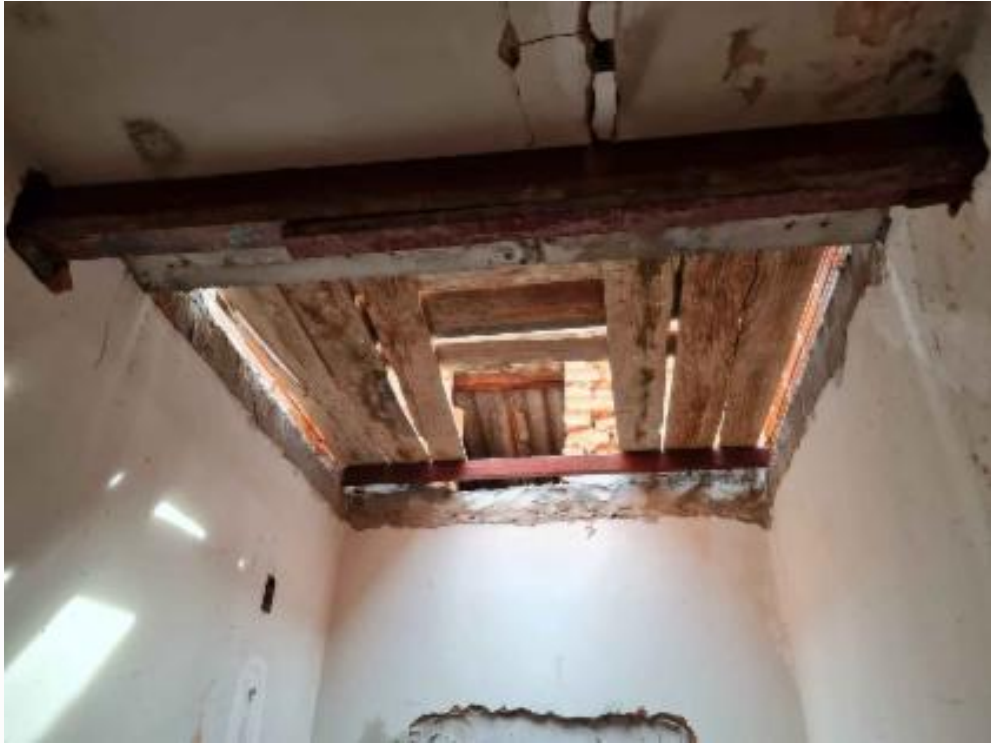
Cobertura banheiro social
