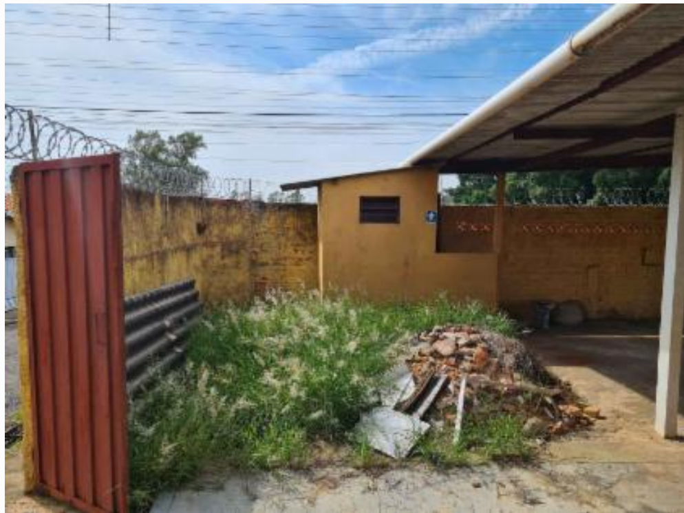
Frente interna do imóvel
