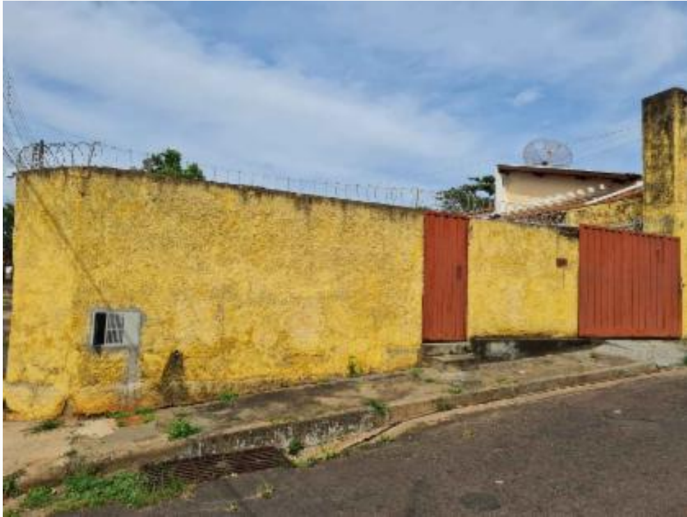
Fachada Frontal do Imóvel
