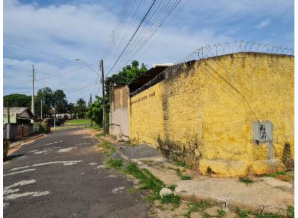
Fachada Lateral do Imóvel
