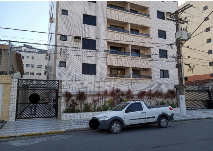
Representação Fachada Principal Descrição Data Foto 06/06/2024
