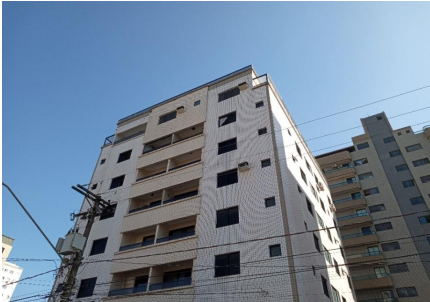
Representação Fachada Principal Descrição Data Foto 06/06/2024
