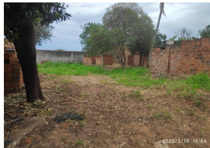
Representação Fachada Principal Descrição Data Foto 21/02/2025
