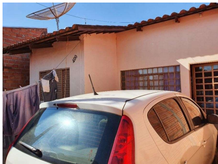
Representação Fachada Principal Descrição Data Foto 09/06/2021
