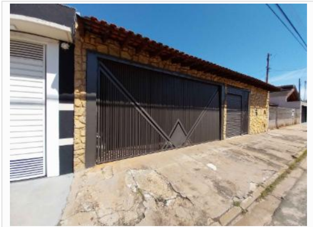
Fachada da Casa
