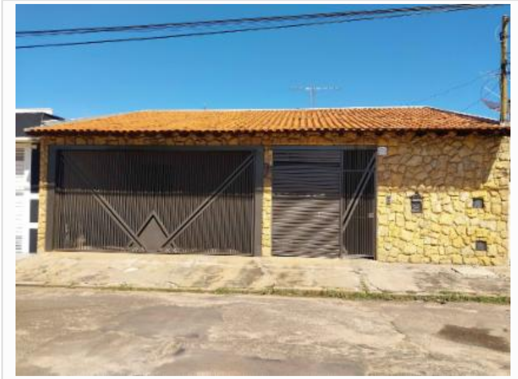
Fachada da Casa
