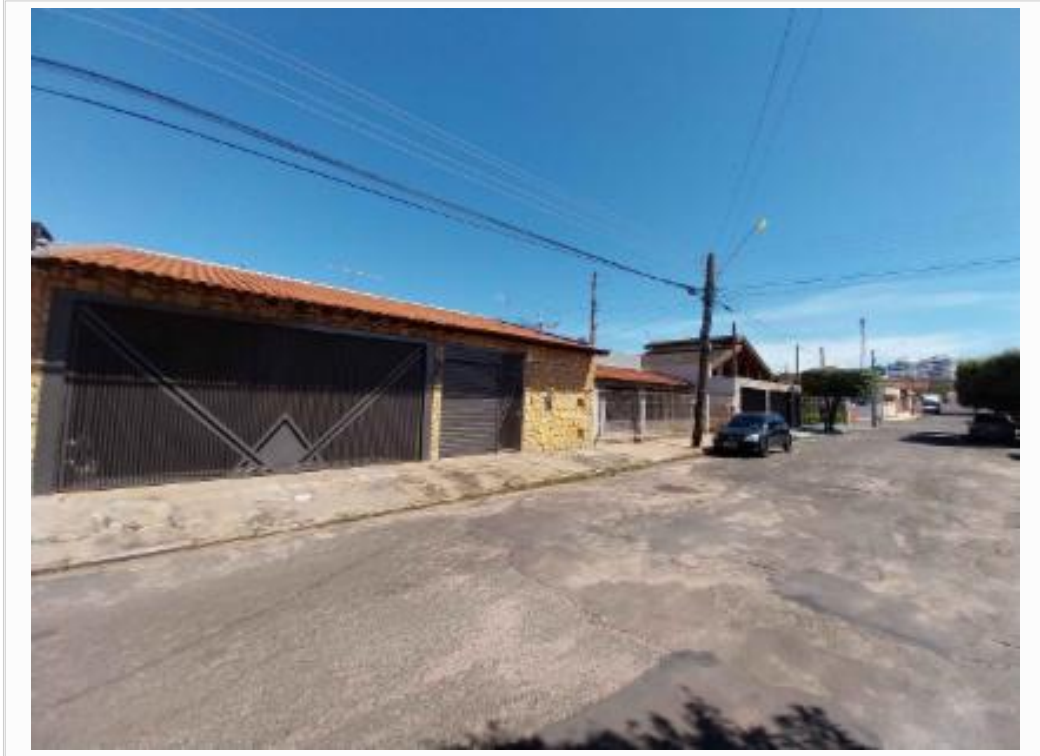
Fachada da Casa
