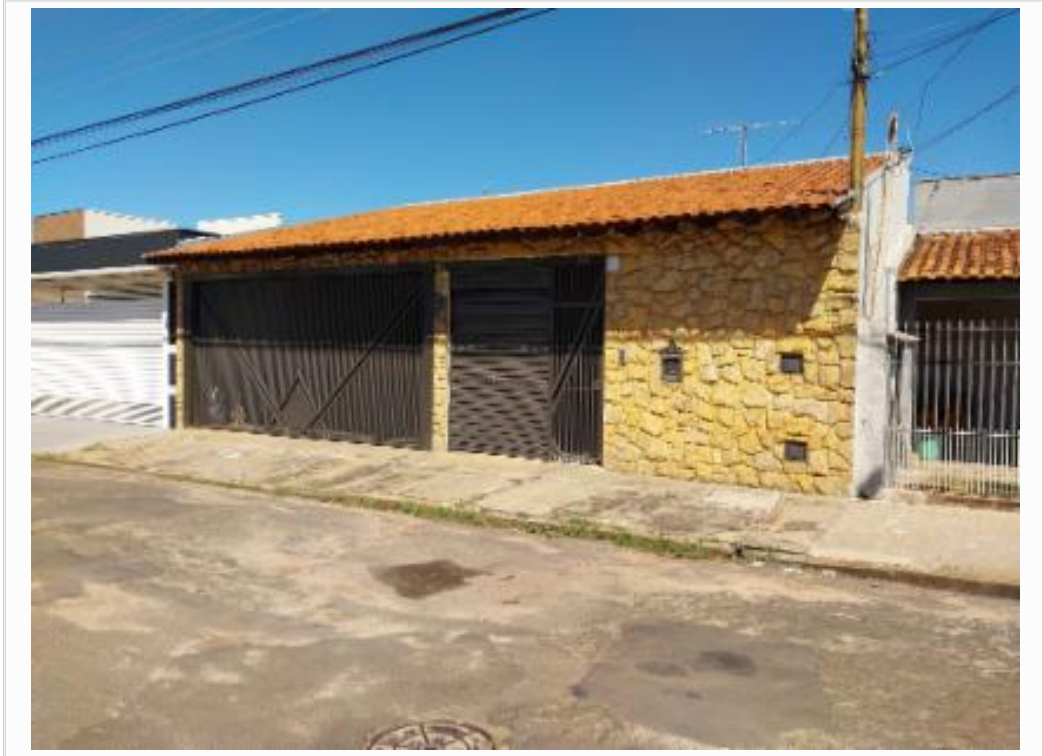
Fachada da Casa
