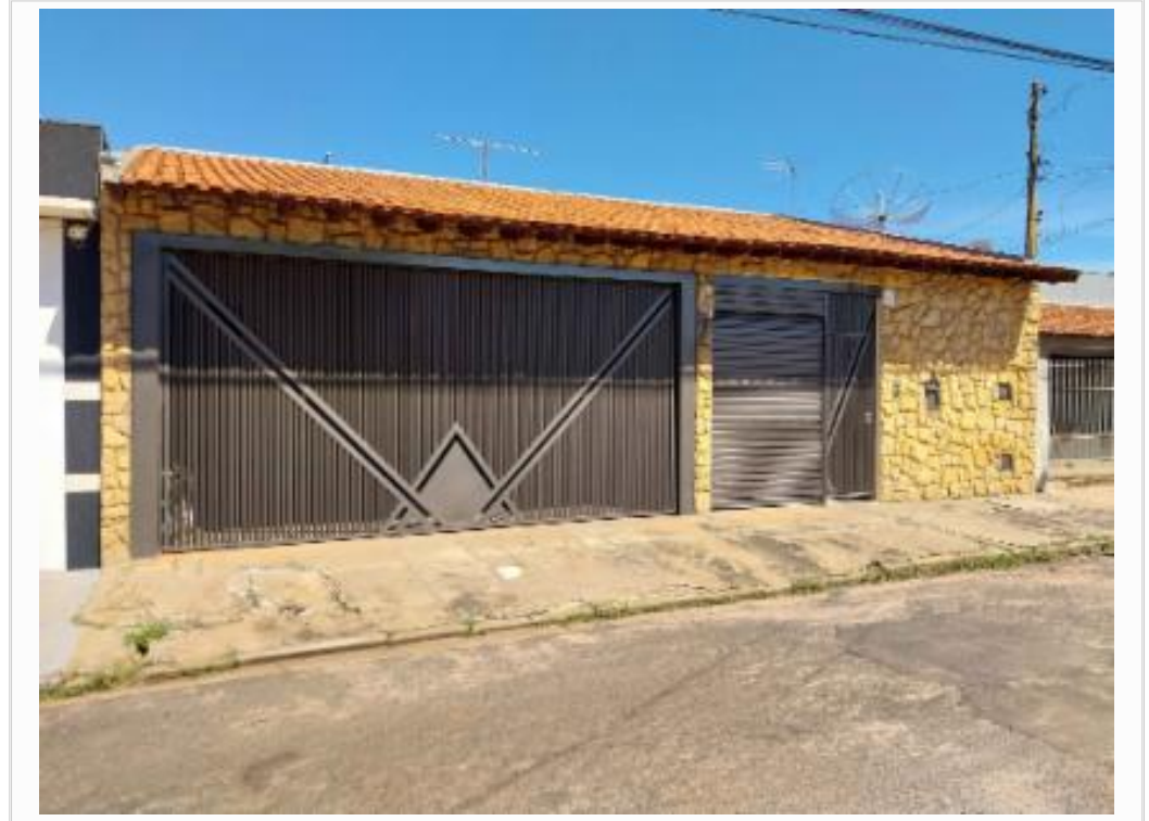
Fachada da Casa
