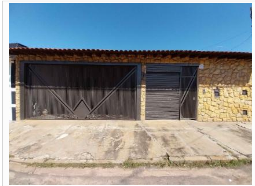
Fachada da Casa
