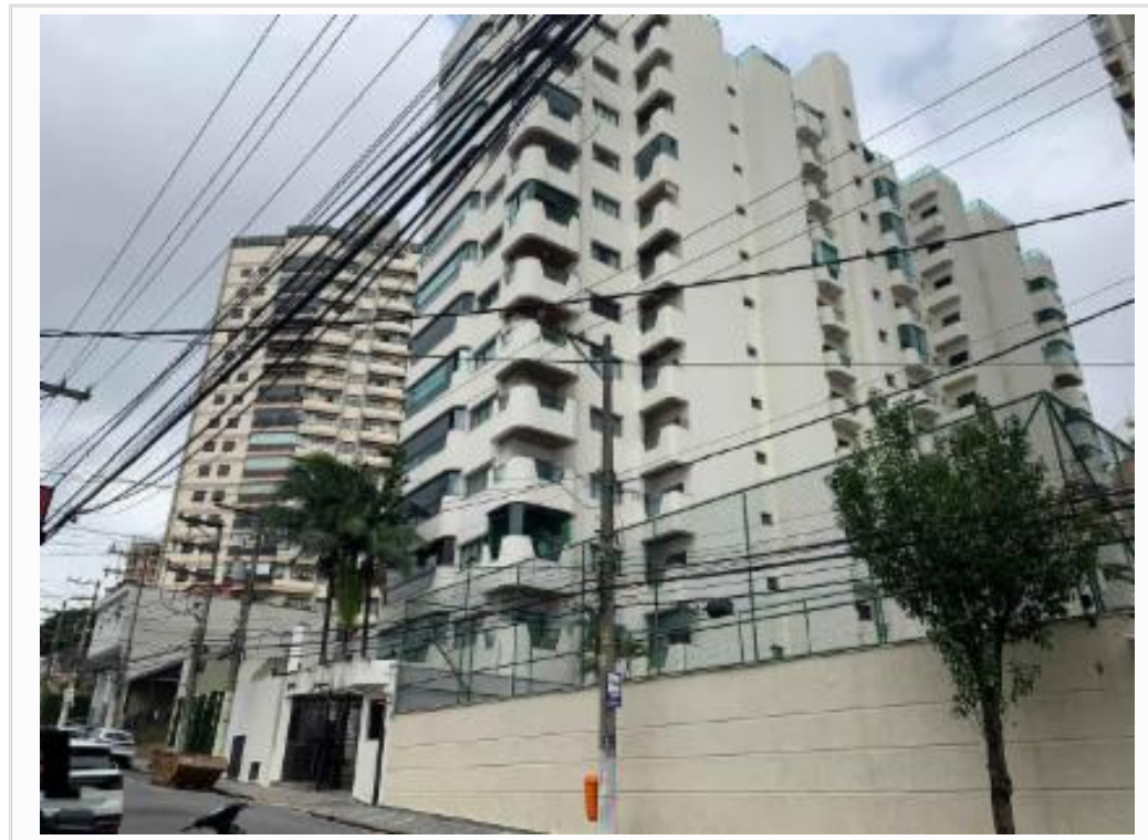
vista parcial da fachada
