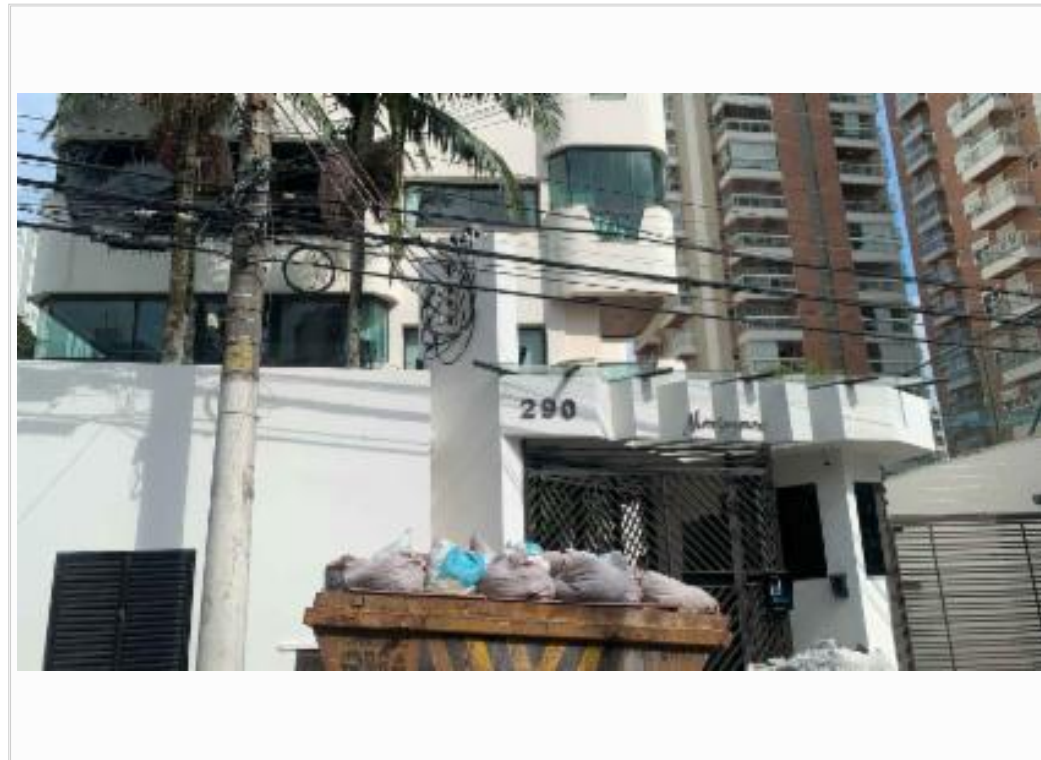
vista parcial da fachada
