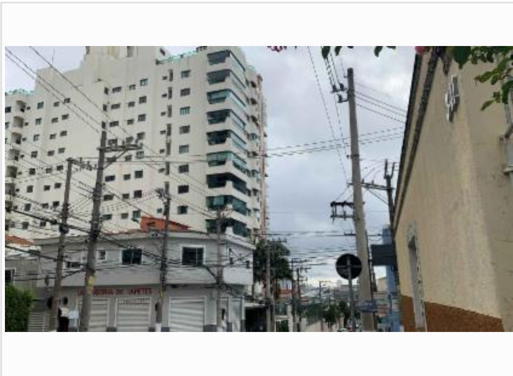
vista parcial da fachada
