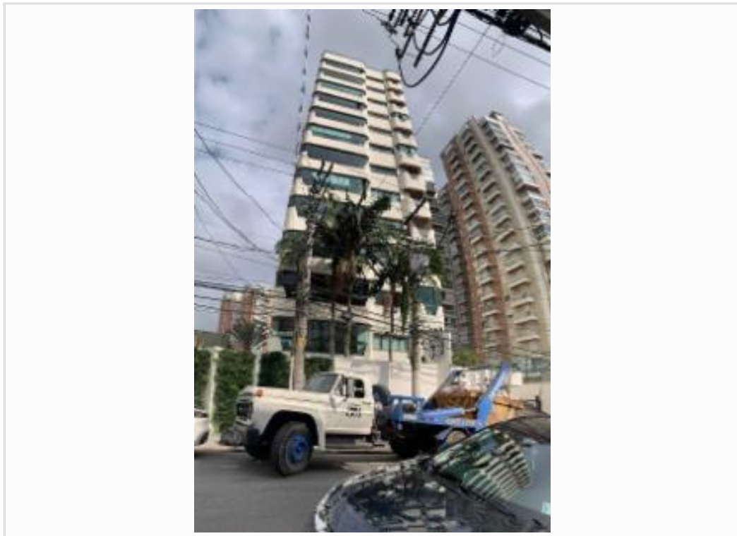
vista parcial da fachada
