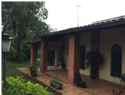
Representação Fachada Principal Descrição Casa principal Data Foto 15/01/2021
