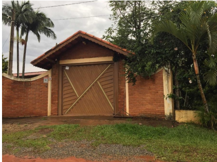
Representação Vista da Rua Descrição Vizinho Esquerda Data Foto 15/01/2021
