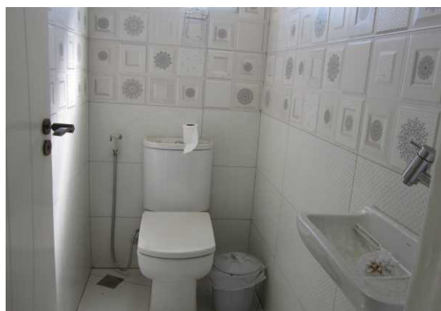
Banheiro 4 - 2º Pavimento
