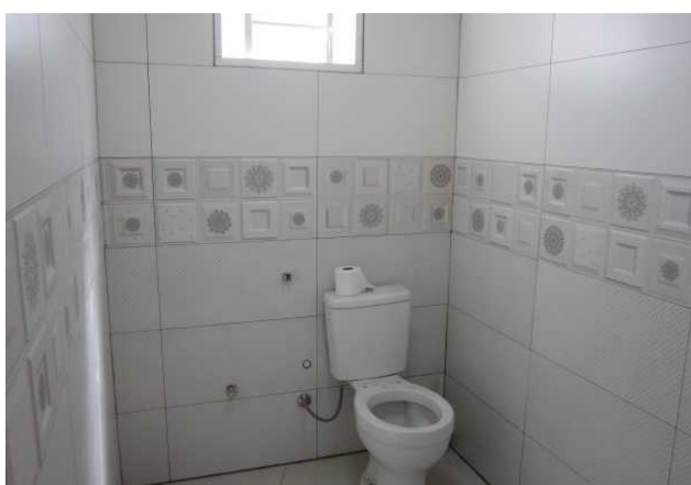
Banheiro 1 - 1º Pavimento
