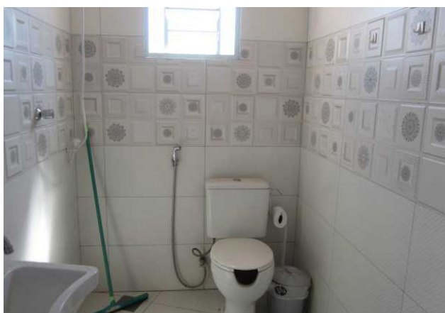
Banheiro 3 - 2º Pavimento
