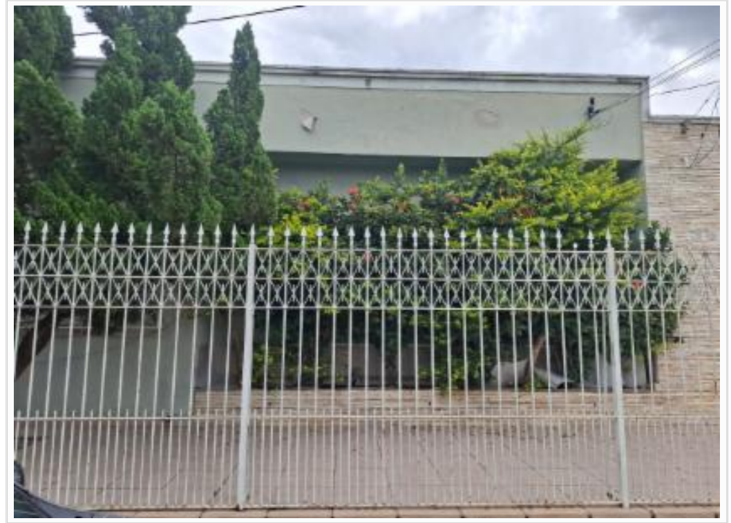
Vista parcial da fachada
