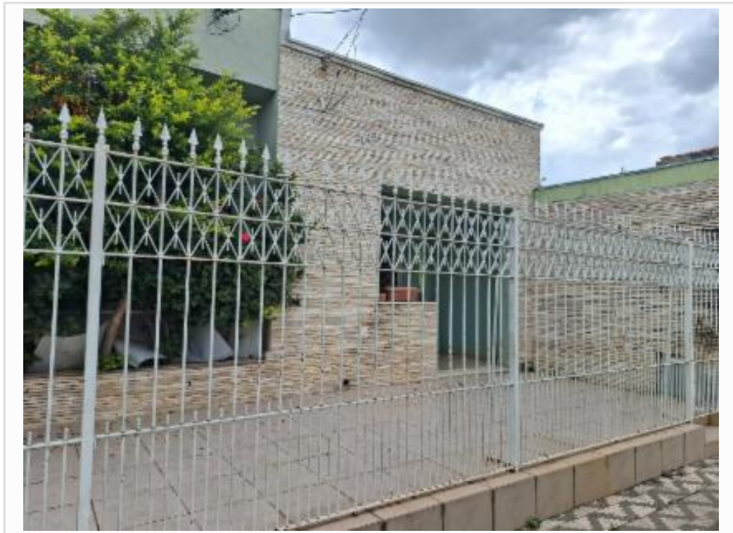
Vista parcial da fachada
