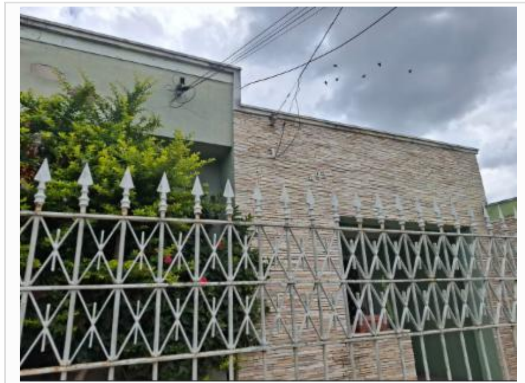
Vista parcial da fachada
