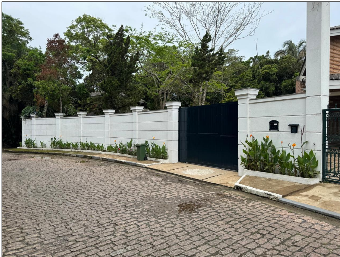
FACHADA DO IMÓVEL AVALIANDO.
