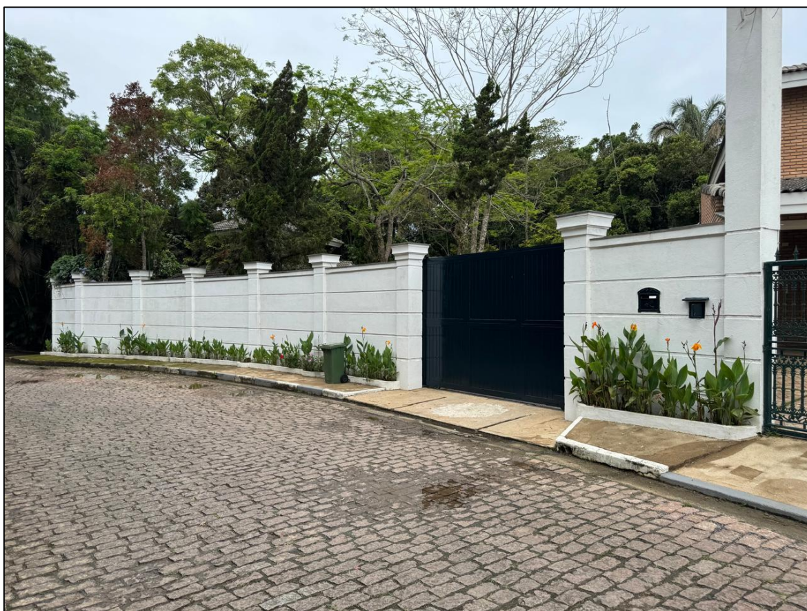
FACHADA DO IMÓVEL AVALIANDO.
