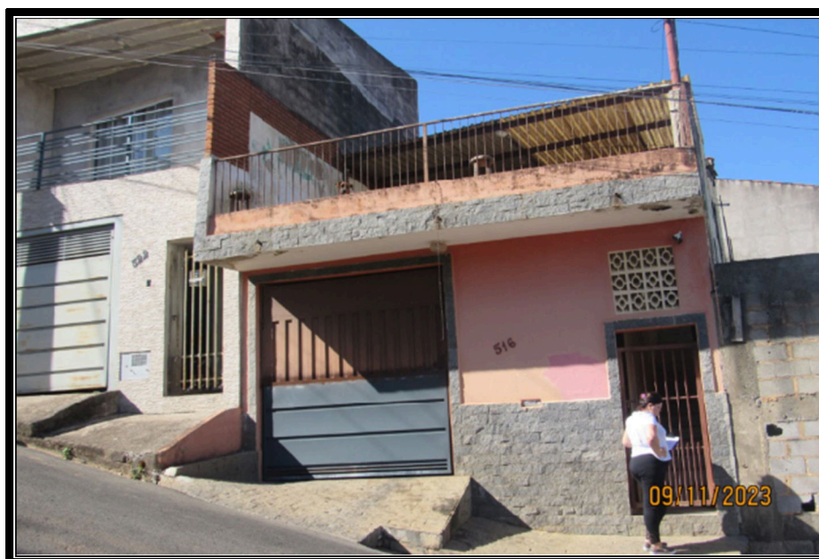
VISÃO DA FRENTE DO IMÓVEL AVALIANDO
