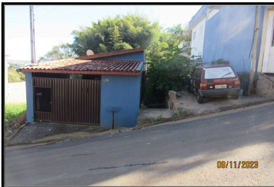
VISÃO DA RUA PARA QUEM OLHA DE FRENTE DO IMÓVEL AVALIANDO
