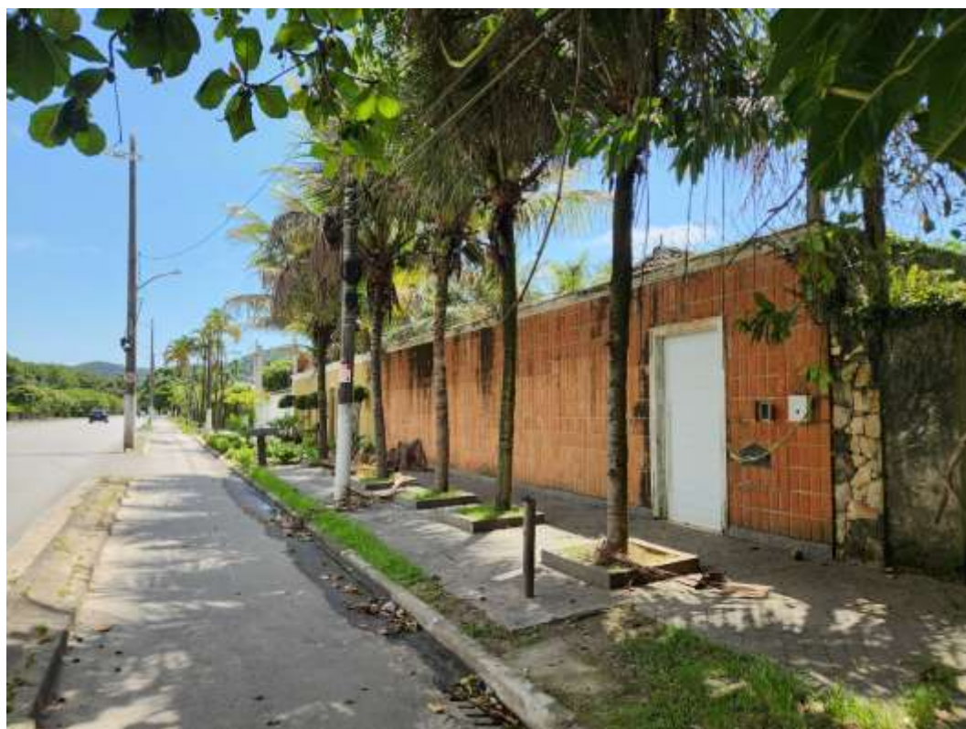
Vizinhança à esquerda do imóvel quando observado a partir do logradouro público.
