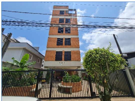
Foto 1 – Vista da fachada frontal do edifício Nautilus
