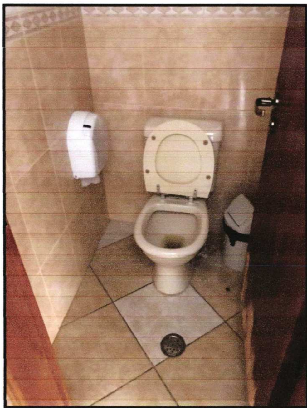
Foto nº 41 – Banheiro do salão de festas.
