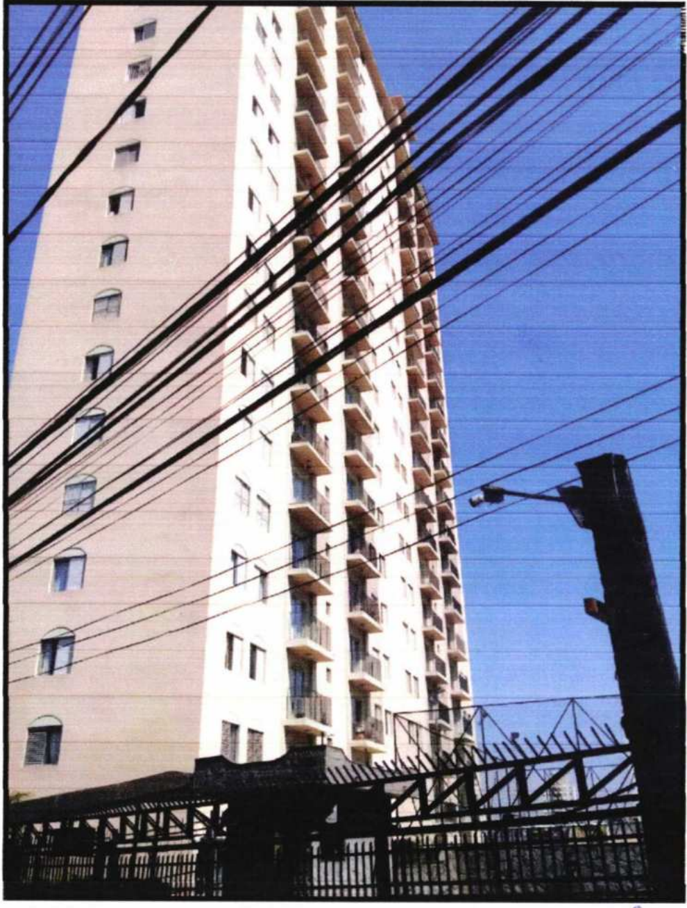
Foto nº 07 – Fachada da torre de apartamentos.
