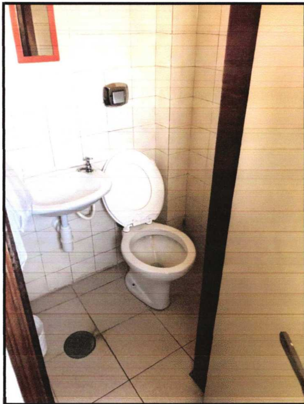
Foto nº 37 – Aspecto do banheiro de serviço.
