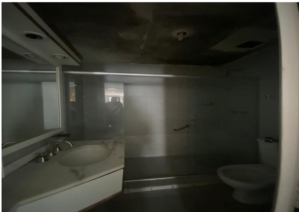
Vista do banheiro da unidade avalianda
