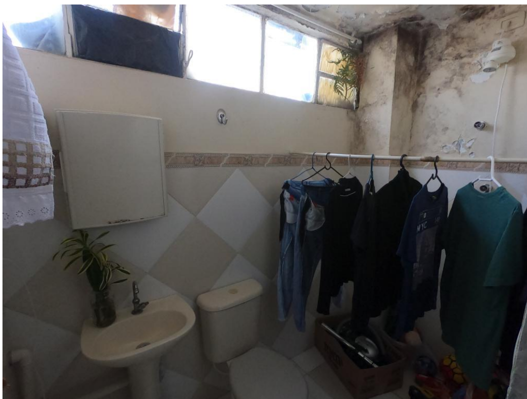
Figura 22. Banheiro do quarto 1.
