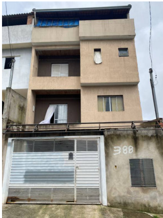
VISTA DA ENTRADA DO IMÓVEL.
