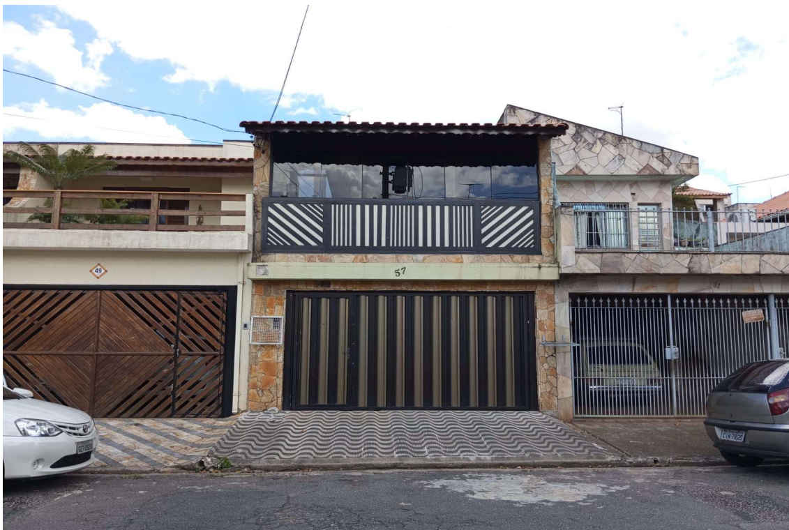
FOTO n° 03 Vista da fachada do imóvel, objeto da presente ação.
