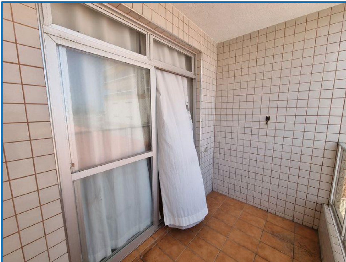
Foto 24 – Vista da varanda do imóvel avaliando e seus acabamentos.
