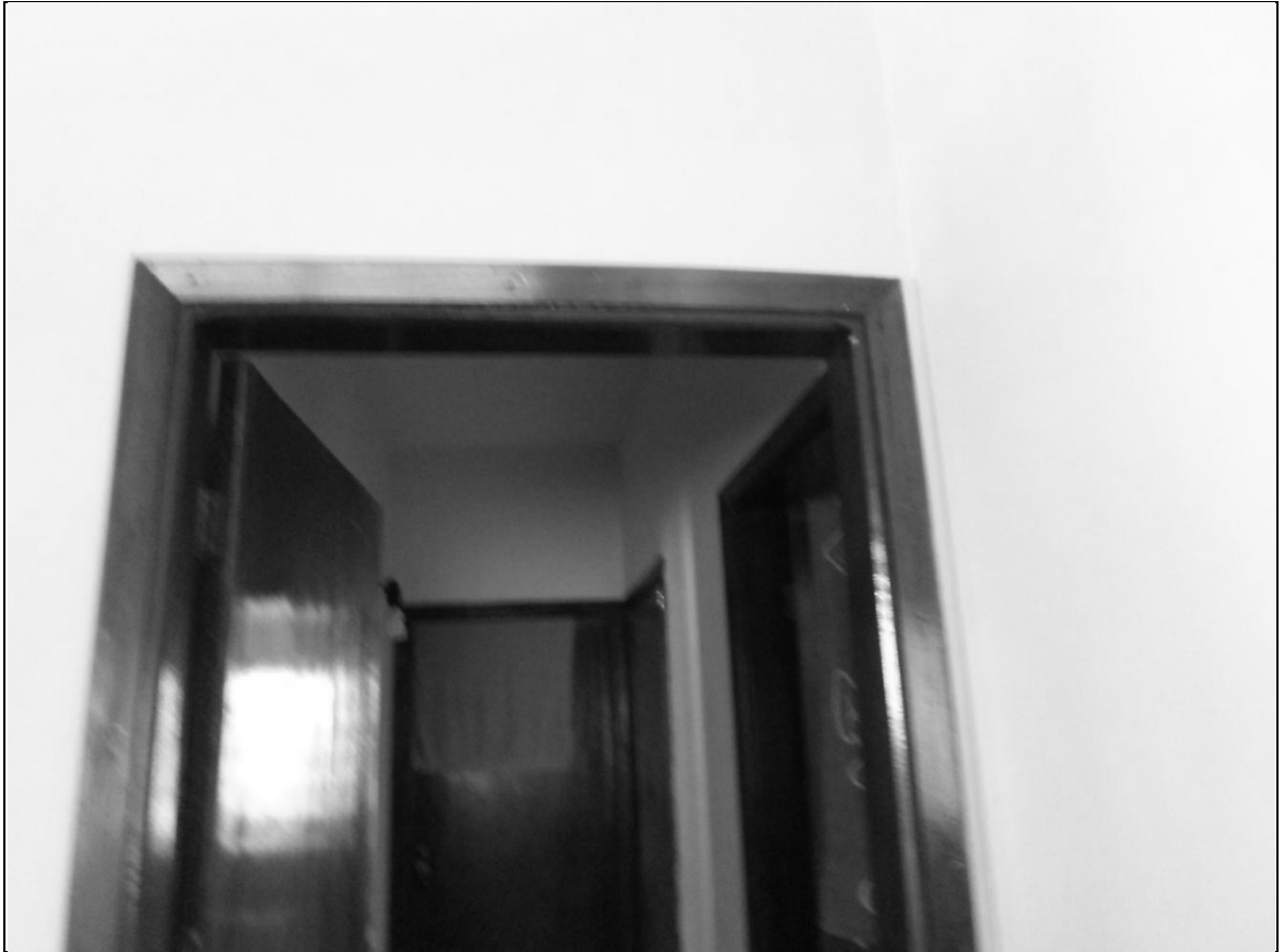
Foto 05 – Vista interna, hall.
