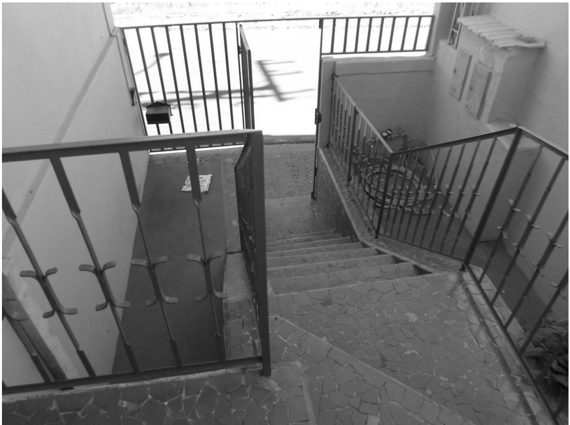
Foto 12 - Vista parcial da entrada.
