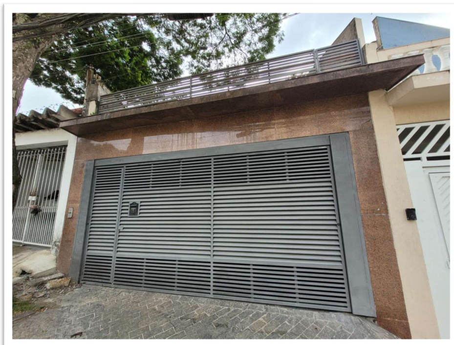
FOTO 01 – FACHADA FRONTAL DO IMÓVEL AVALIANDO
