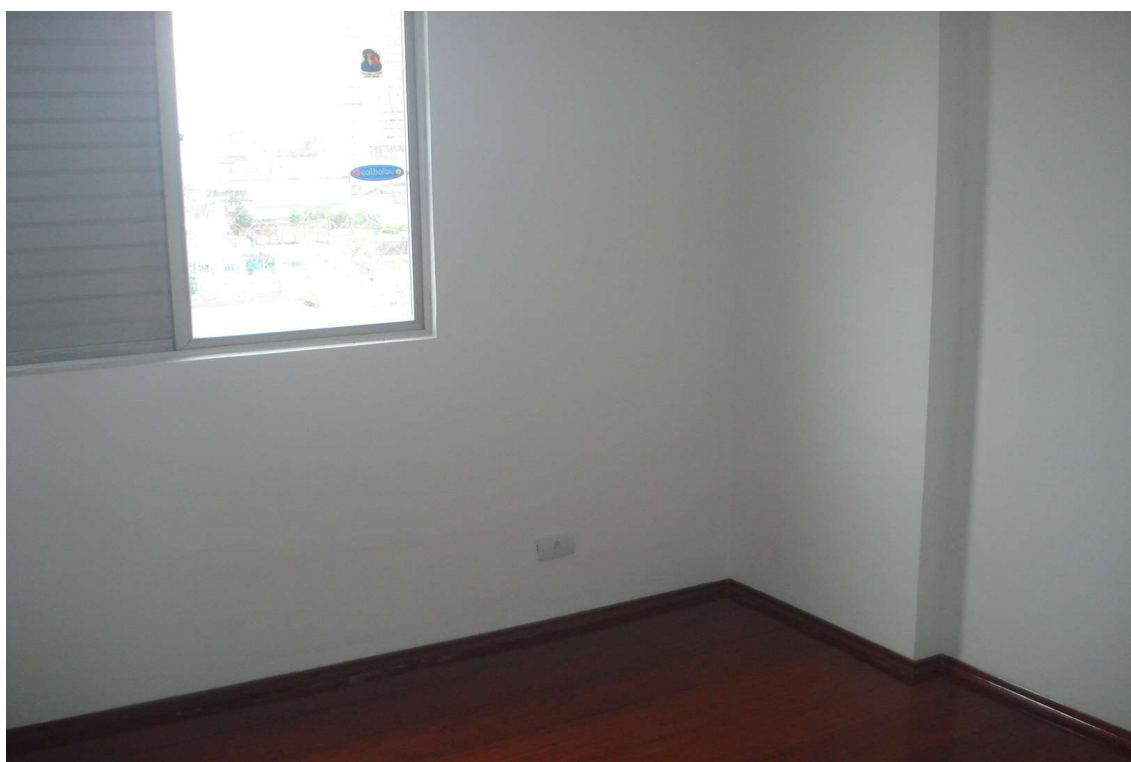
FOTO Nº 14 – Vista do terceiro dormitório no apartamento paradigma.
