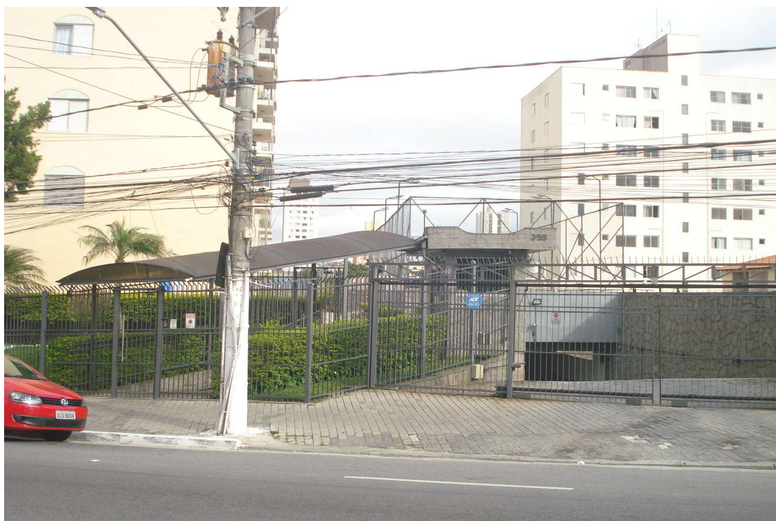
FOTO Nº 04 – Vista da portaria no Condomínio Jardim Passaredo.
