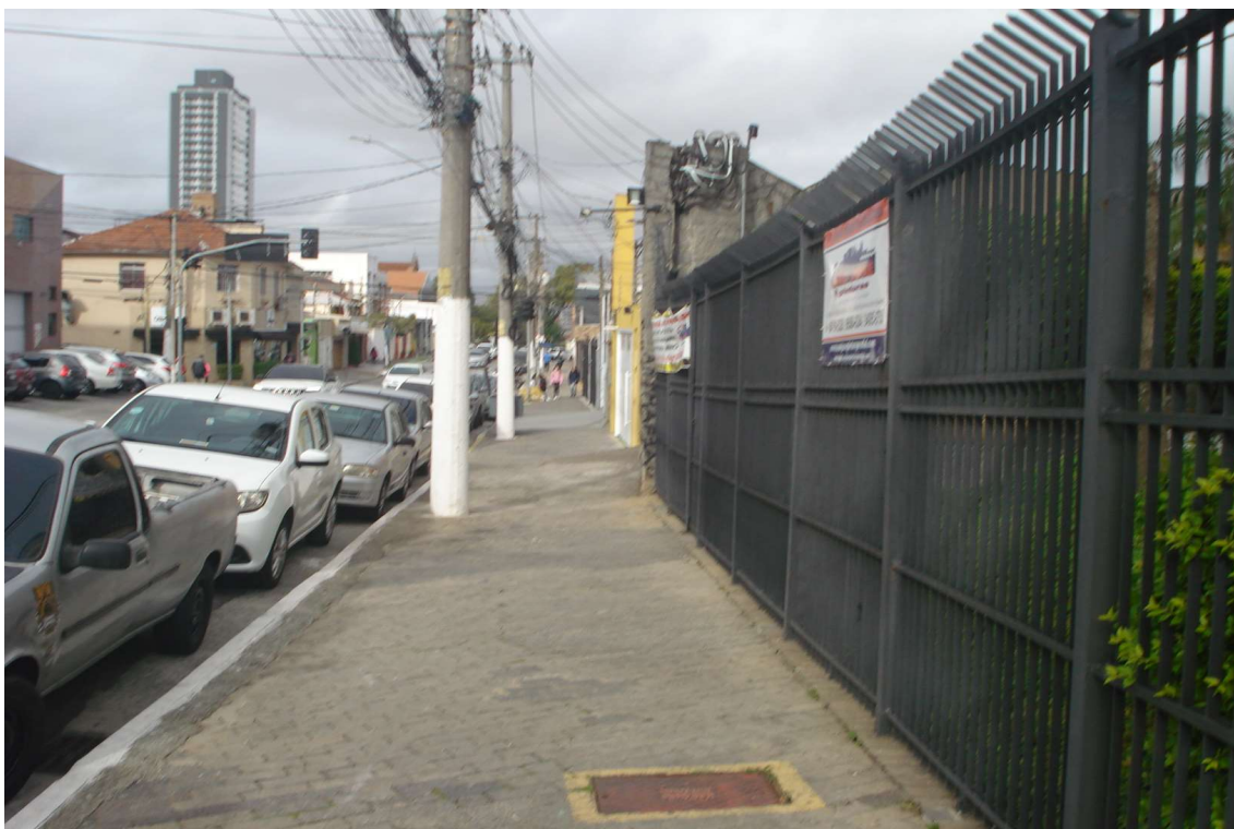
FOTO N° 02 – Vista da Avenida Padress Olivetanos à esquerda do Condomínio Jardim Passaredo.
