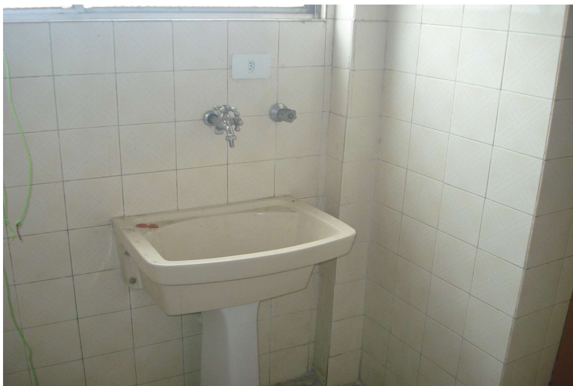
FOTO Nº 10 – Vista da área de serviço no apartamento paradigma.
