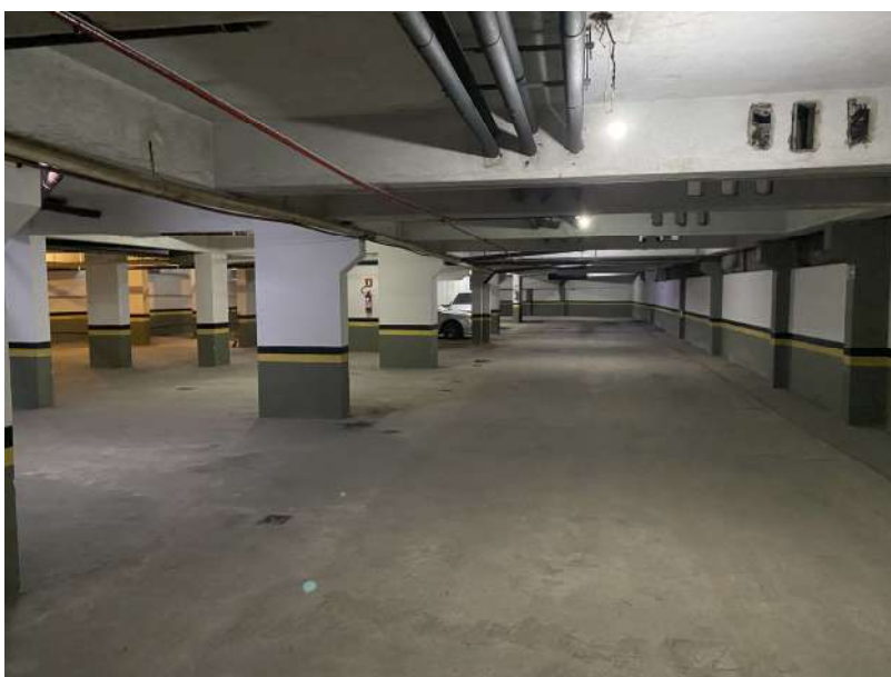
Imagem 12 - Vista da garagem, localizada no pavimento subsolo.
