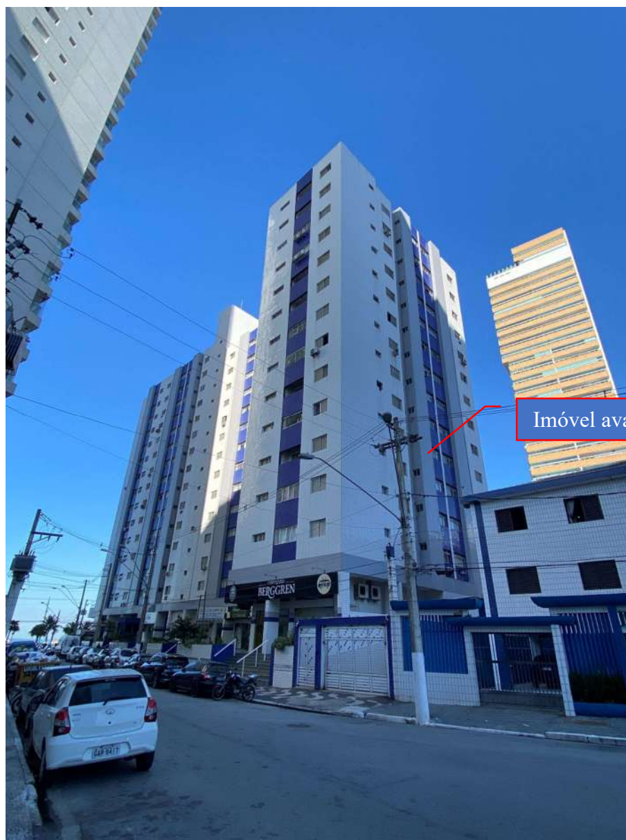
Imagem 2 - Vista da fachada dos fundos do condomínio pela Rua Luiz Antônio de Andrade Vieira.
