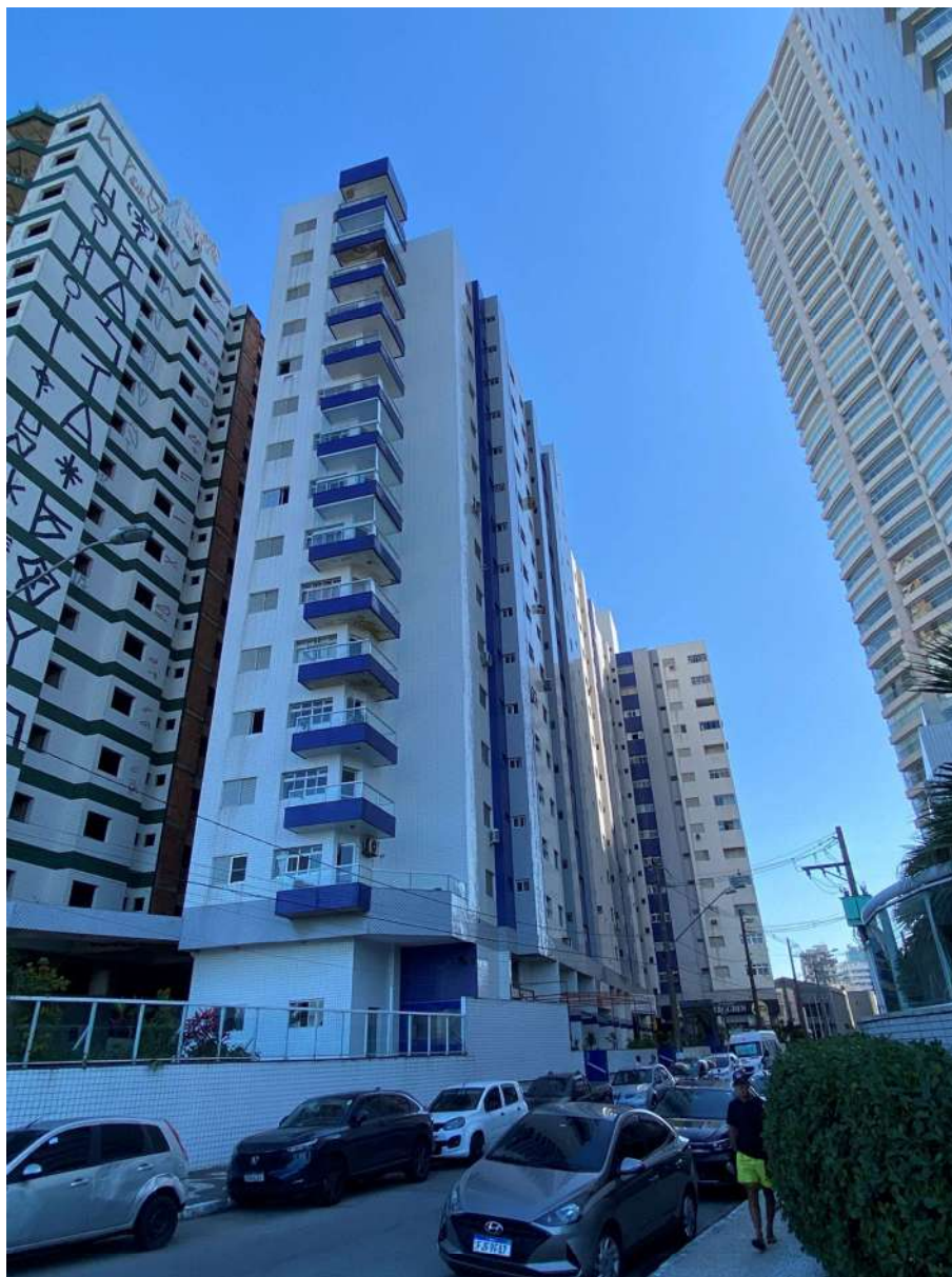
Imagem 1 - Vista da fachada do condomínio.
