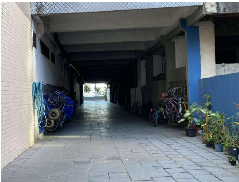
Imagem 7 - Vista do bicicletário, localizado no térreo.
