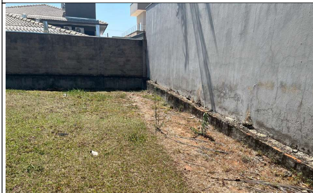
Foto 07. Vista do muro de arrimo na lateral do lote
