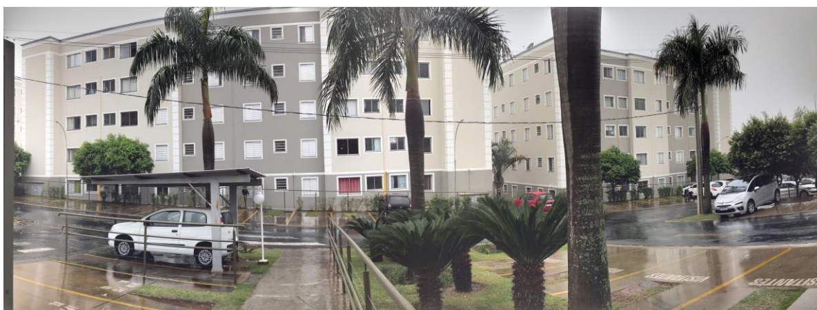
Figura 3 - Vista panorâmica do Bloco 3 do Condomínio Residencial Spazio Belluno.
