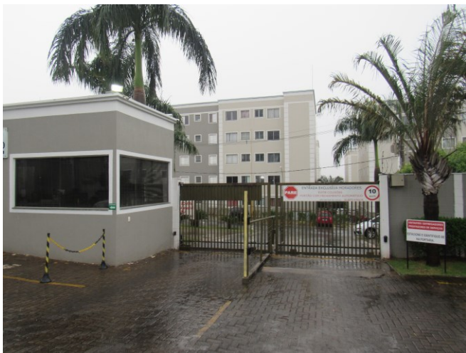
Vista do acesso ao Condomínio Spazio Belluno.
