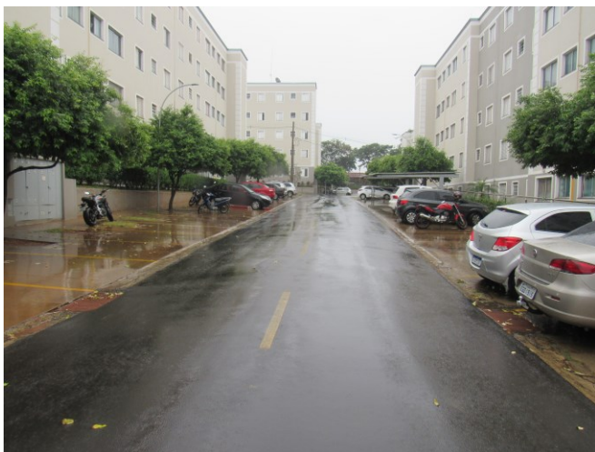
Vista da via de circulação do Condomínio.
