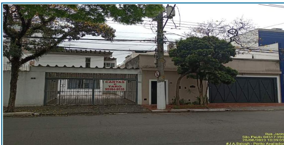
Foto 4 – Imóvel Vizinho (Residencial) à Esquerda, 85
