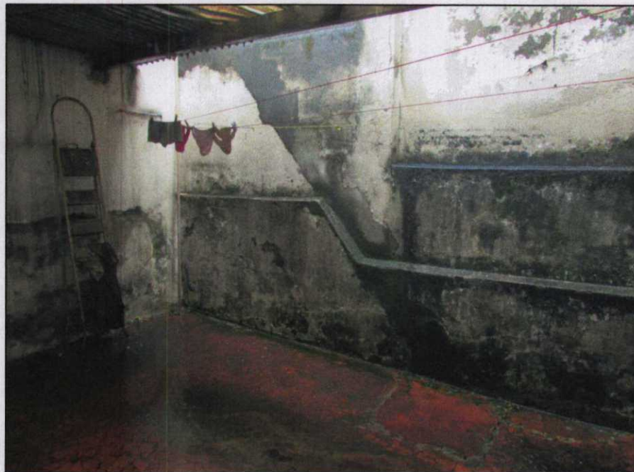
Foto 09:.. Área nos fundos do imóvel com piso cerâmico, paredes revestidas com acabamento e pintadas com tinta látex.
