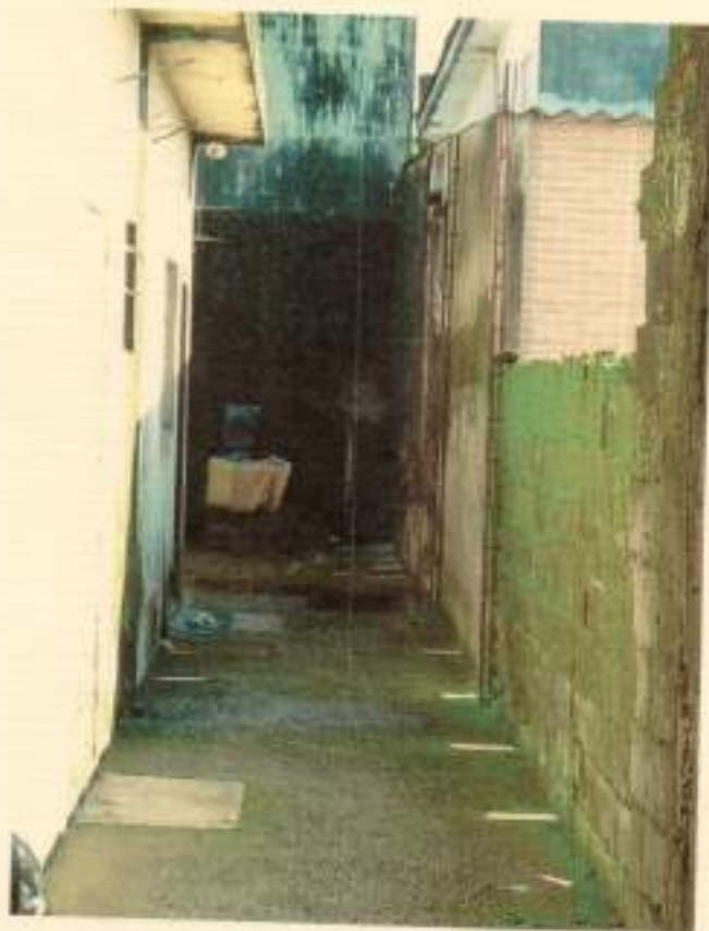
VISTA DOS FUNDOS DO IMÓVEL.
