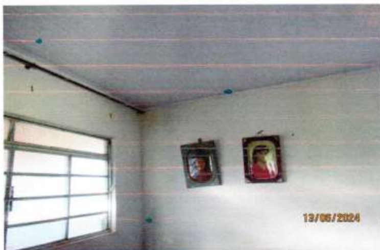
FOTO N° 4 Vista interna da sala - forro em PVC
