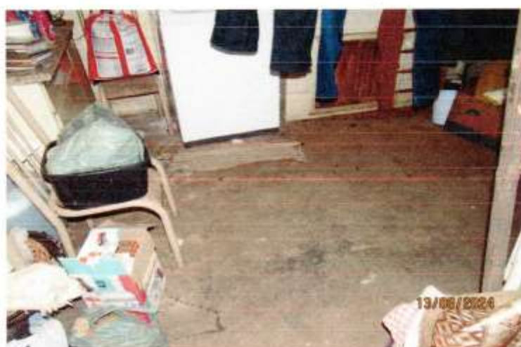
FOTO N° 8 Aspecto geral da área de serviço
